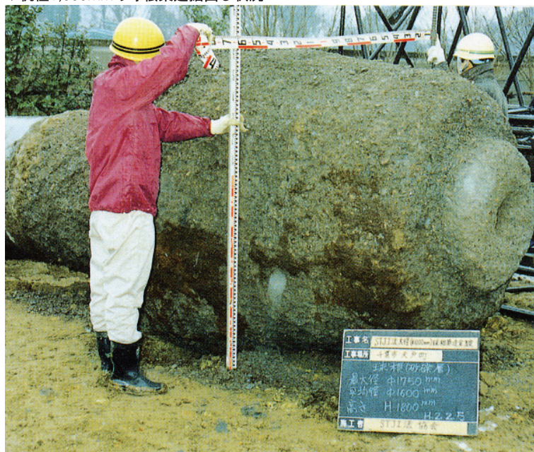
▼杭径1,000mmの球根築造掘出し状況
