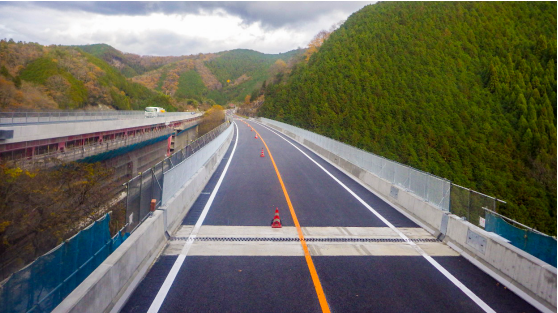
中国自動車道 千種川橋
