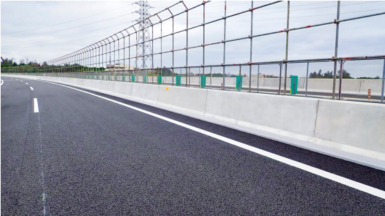
沖縄自動車道 億首川橋
