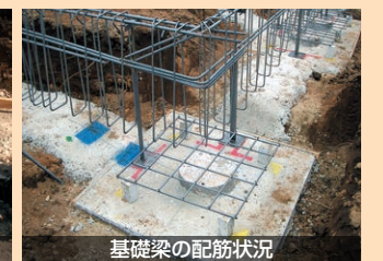
基礎梁の配筋状況
