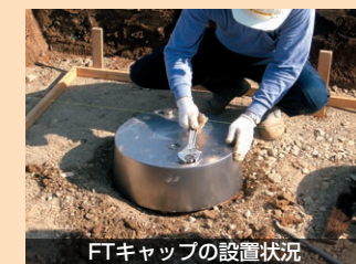
FTキャップの設置状況
