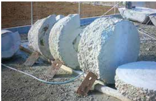
切断状況(全体)
