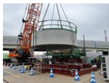
PCウエル工事 (材工一体受注)
