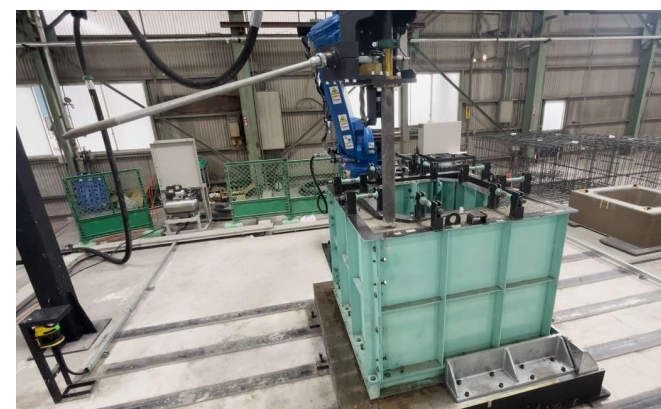
3Dプリント型枠へのコンクリート打設風景
