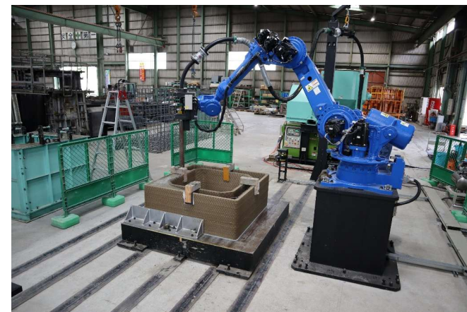
鋼製型枠へのコンクリート打設風景
