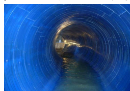
管更生（3Sセグメント工法）
