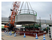
PCウエル工事 (材工一体受注)
