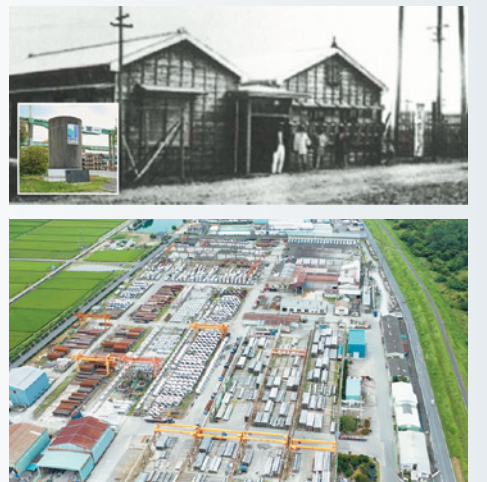
①創業当時の本社(横浜市鶴見)と日本で最初のヒューム管(現在は熊谷工場敷地内に設置) ⑤現在は国内5工場体制。熊谷工場は東京ドーム3.5個分の広さをもち多彩な製品を製造
