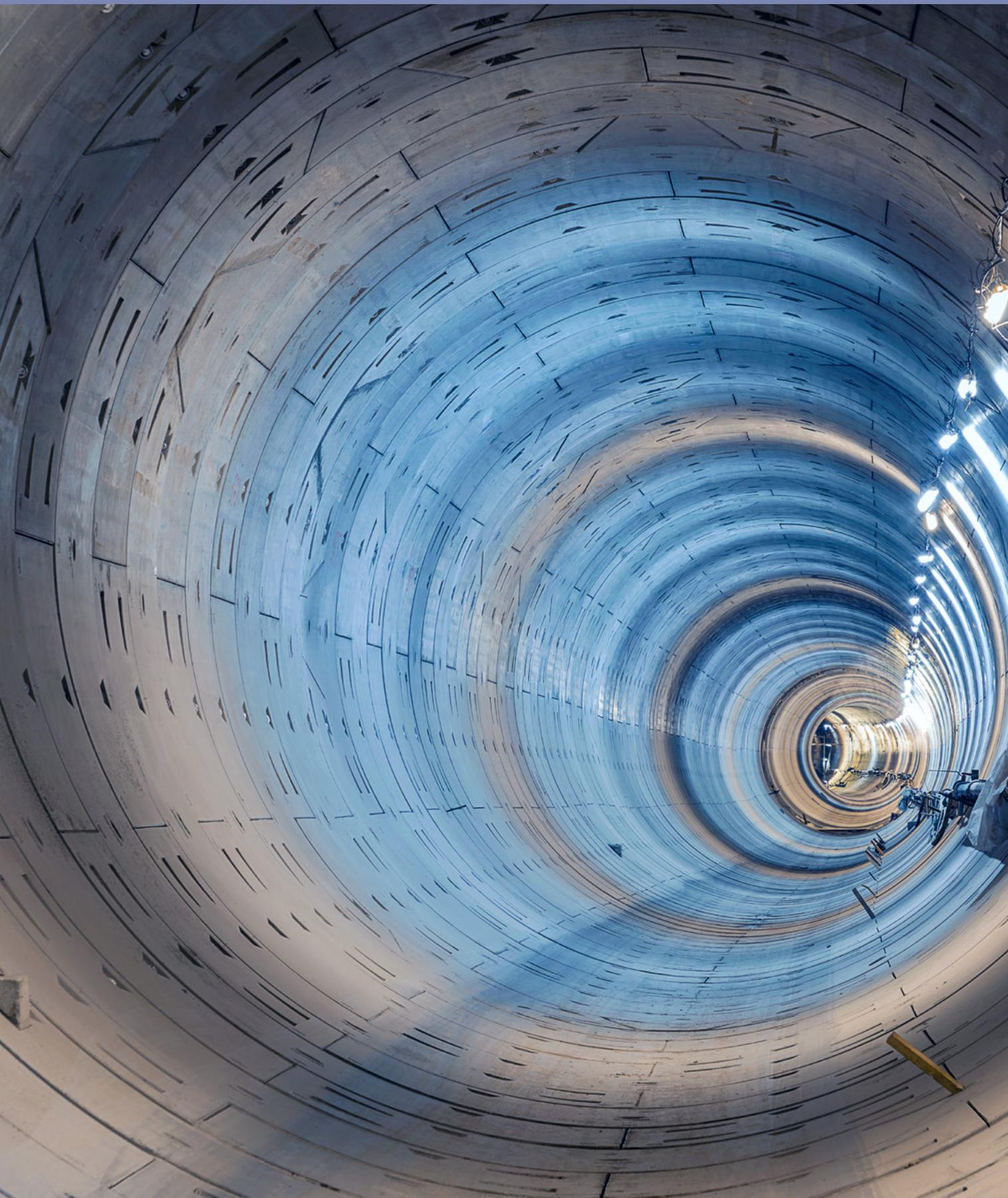
地下をめぐる下水道パイプラインは私たちの生活になくてはならない重要なインフラ構造物です。老朽化・劣化による再構築などは近年の都市化につれ、大変難しいものとなっています。汚水中に含まれる細菌が変化し、酸となってコンクリートを劣化させる問題にe-CONは貢献します。大切なインフラをより永く使えるように。
