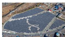
太陽光発電所
