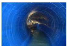
管更生（3Sセグメント工法）
