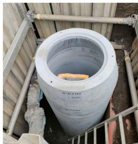
■ e-CONを使用したマンホールによる実試験施工を実施。
