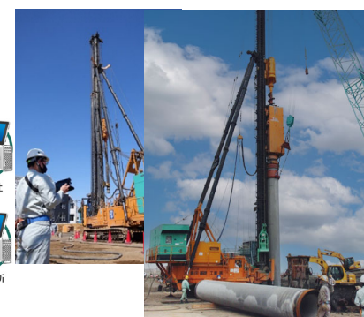
New-STJ-Ⅱ 工法 (中掘工法)
