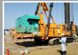
「i-Pile-ViMSys」による作業風景
