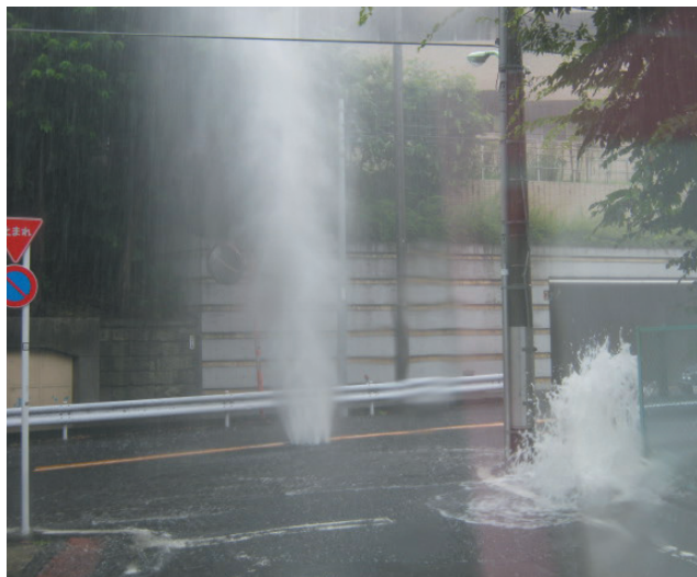
マンホールから水が噴き出している様子
