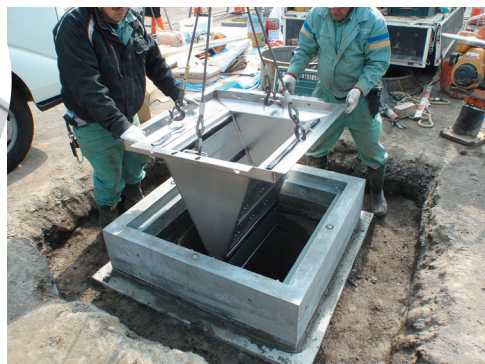
装置設置の施工状況
