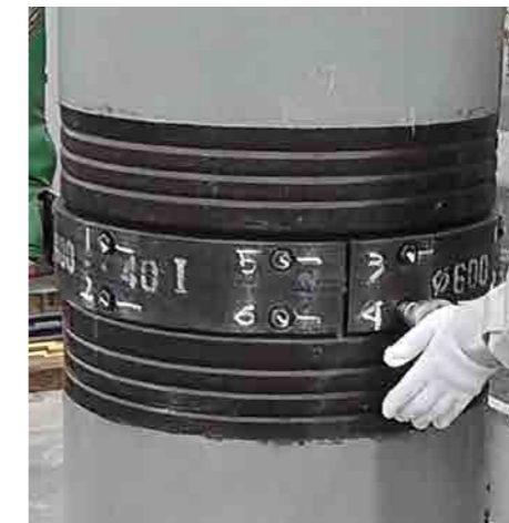
本締め完了後、ボルト頭部とプレートのマーキング のズレを確認する。
