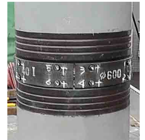
トルクチェック完了後、プレートにマーキングする。
