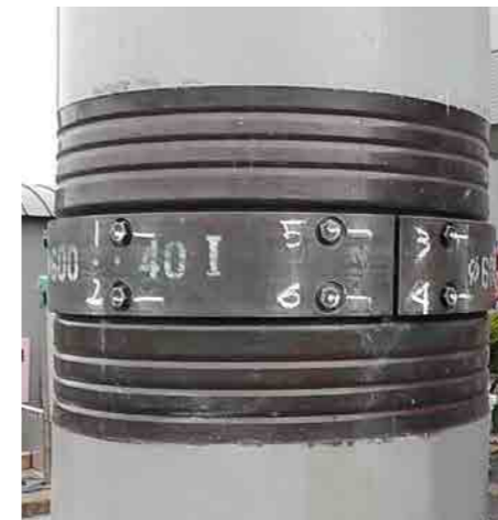
一次締め完了後、ボルト頭部からプレートにかけて 一本線でマーキングする。
