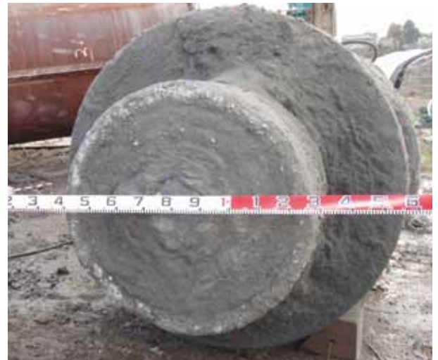
根固め部掘出し
