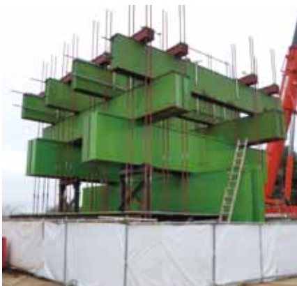
鉛直載荷試験
