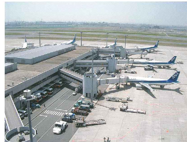
羽田国際空港・西旅客ターミナルビル
