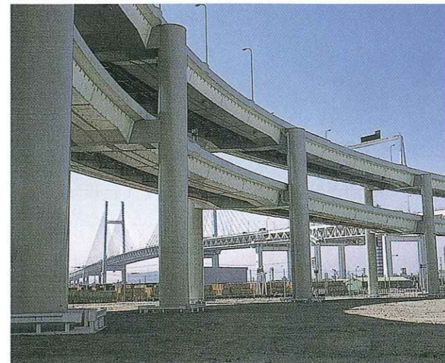
横浜 大黒埠頭インターチェンジ
