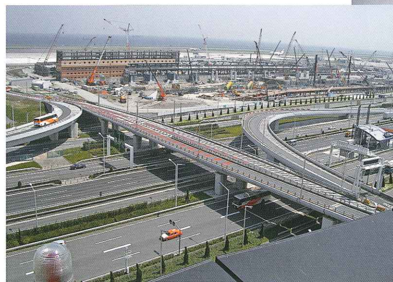
羽田国際空港・東旅客ターミナルビル
