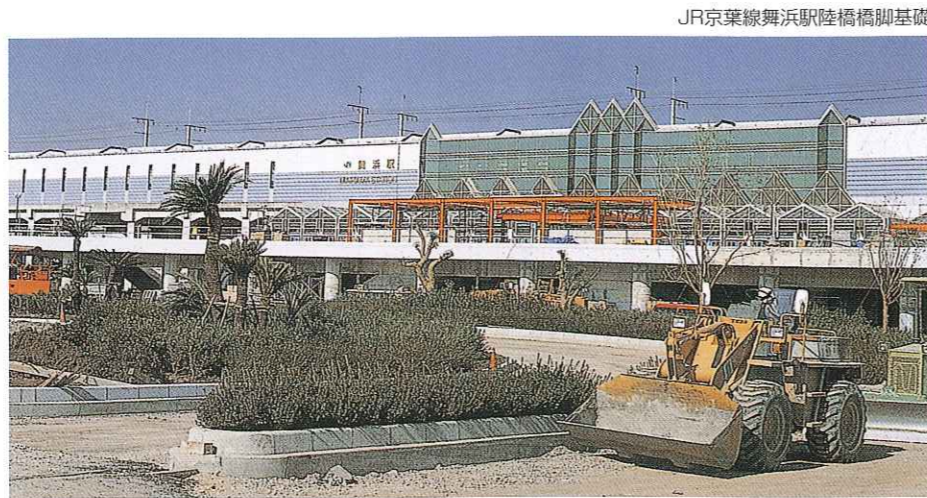
JR京葉線舞浜駅陸橋橋脚基礎
