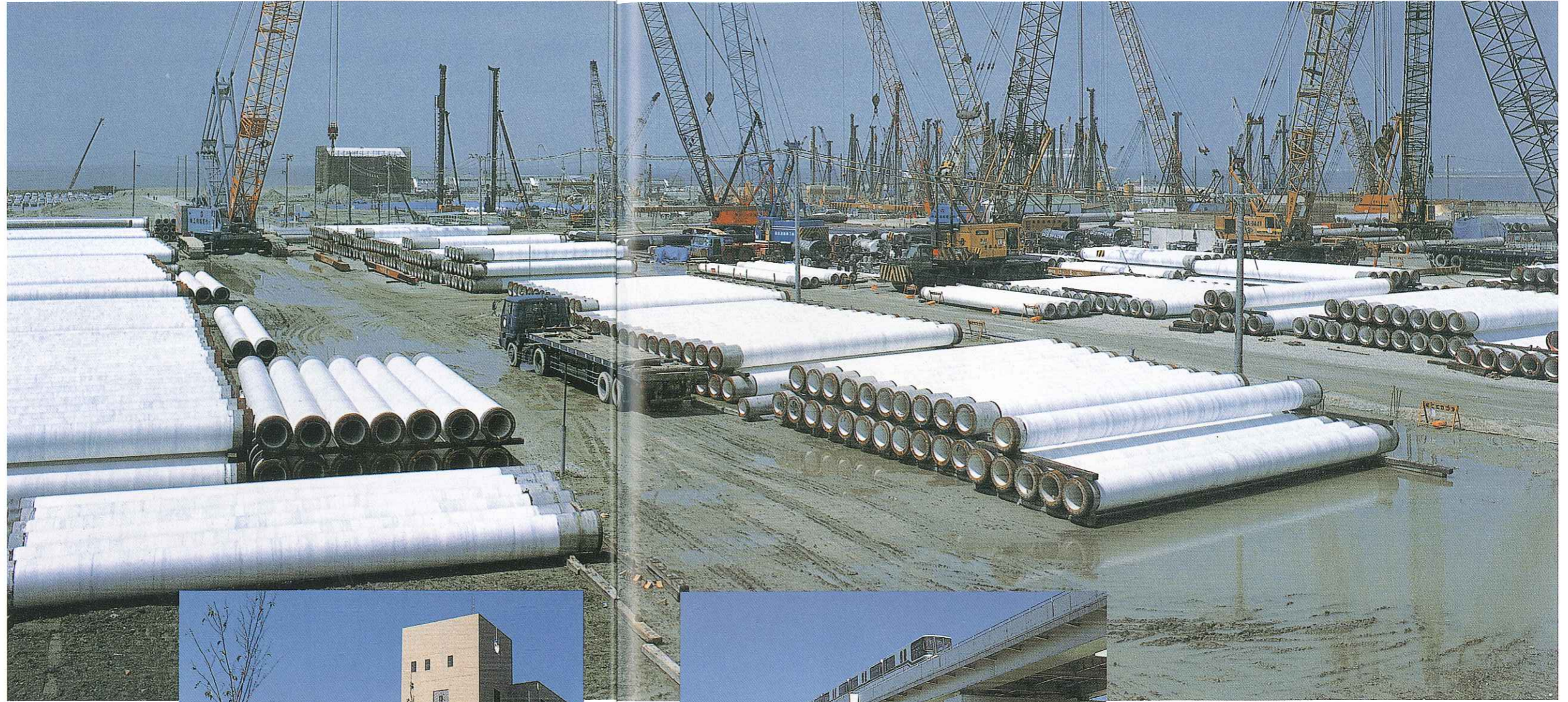
大阪 関西電力大阪南港火力発電所建設工事
