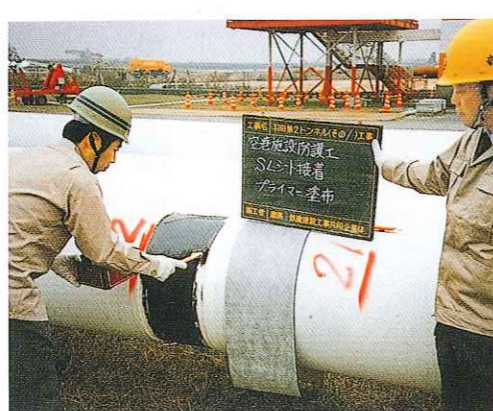
東京 羽田空港 鋼管継手部へのSLシート貼付
