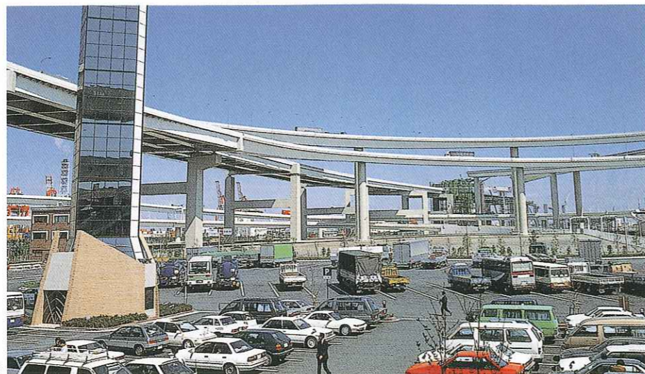
横浜 大黒頭環状インターチェンジ橋脚基礎
