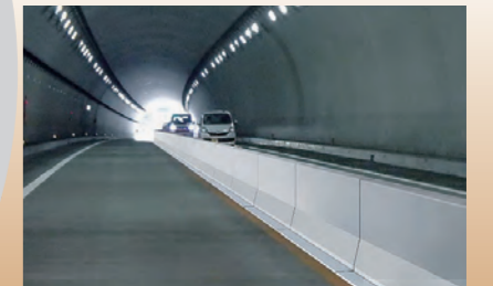
■ RC床版・防護柵
