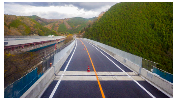
中国自動車道 千種川橋
