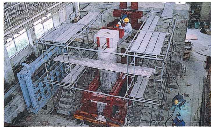
▲正負交番载荷実験状況 (於:建設省土木研究所)
