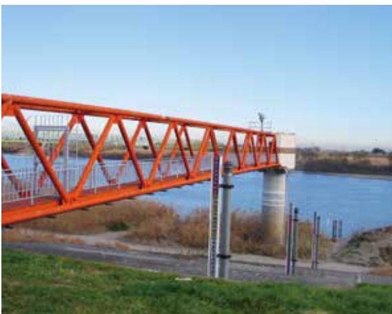
栗橋水位観測塔 (φ2500 PCウェル 建設省利根川上流工事事務所)
