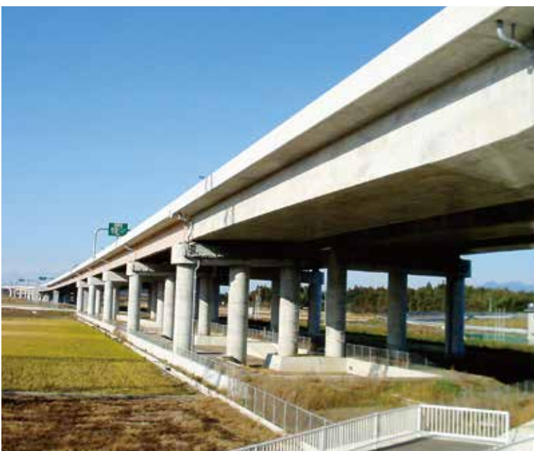
つくば高架橋【圏央道】（ \phi 3000 \sim 3500 PCウェル 基礎 建設省常総国道工事事務所）
