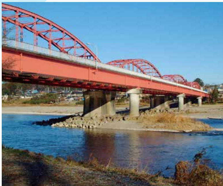
那珂川大橋歩道橋 (φ2500 PCウェル 橋脚基礎一体構造 茨城県水戸土木事務所)
