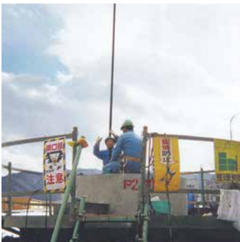
ネジ筋鉄筋挿入状況 (PPRC 構造)
