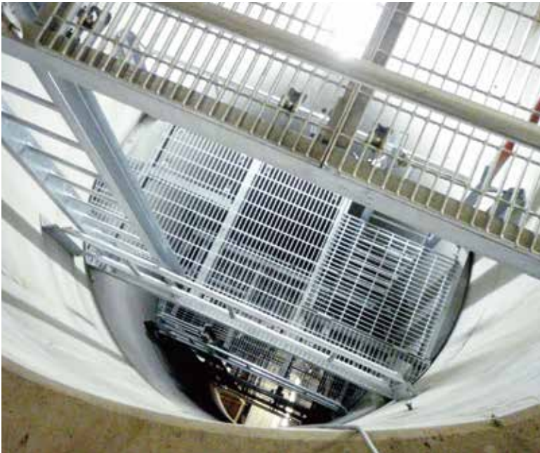
大森蒲田共同溝 (φ2500 PCウェルマン 分岐立坑 国土交通省東京国道事務所)
