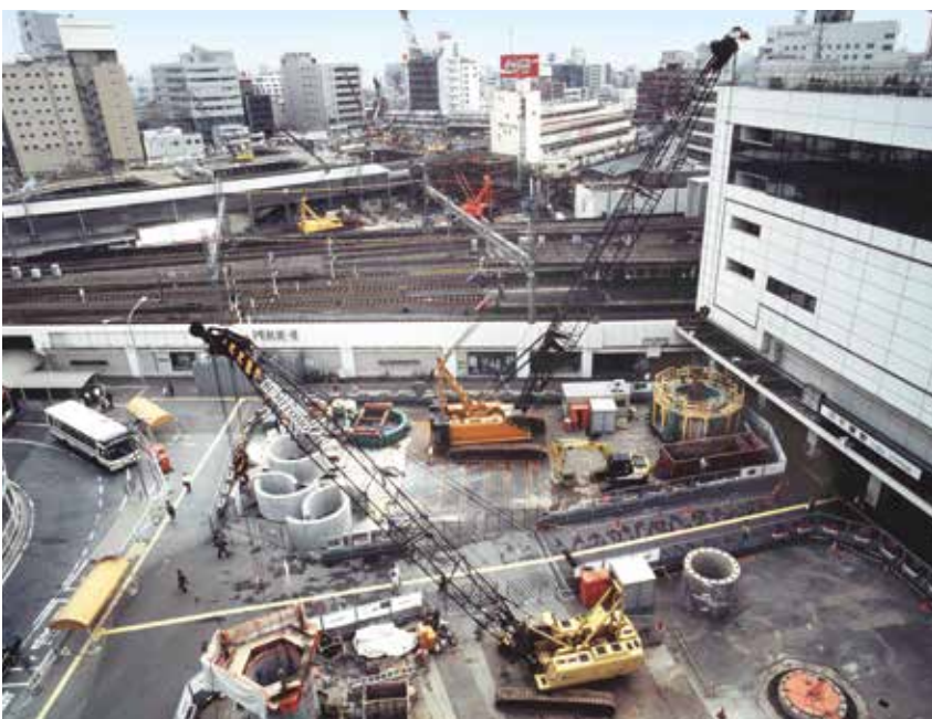
■ モノレール千葉駅新設工事 (φ3000～φ6000 基礎 千葉県千葉都市モノレール建設事務所)
