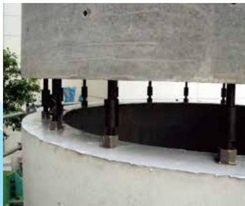
接着剤塗布状況 (PC・PPRC 構造共通)
