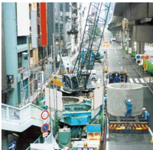
施工時の占用状況
