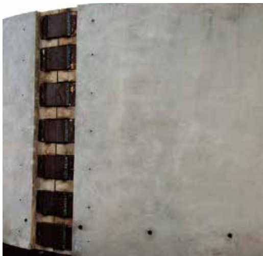
分割ブロック組立状況 (接合部にグラウト充填後沈設)
