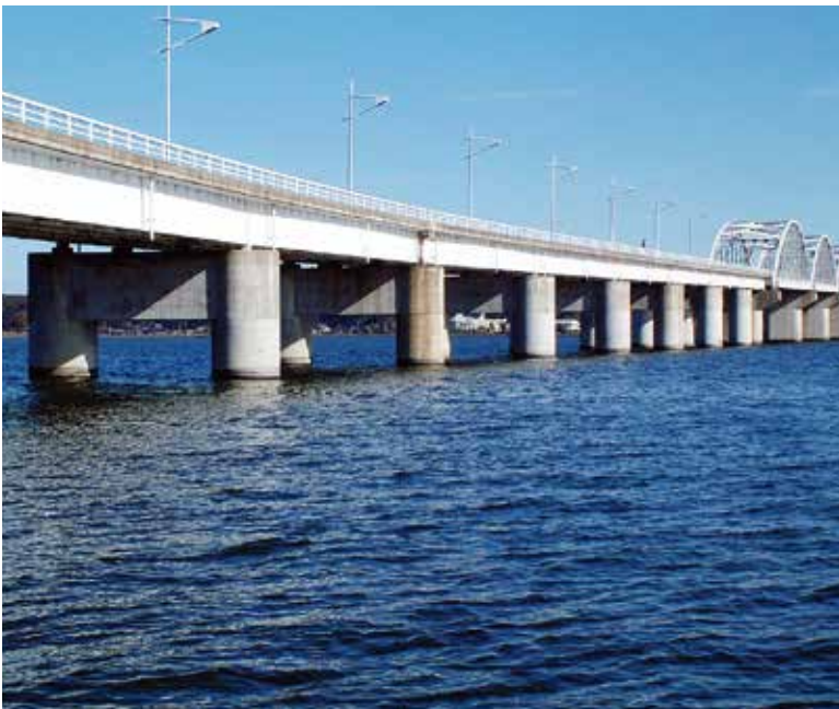
北浦大橋（ \phi 3000 \sim 3500 PCウェル 橋脚基礎一体構造 茨城県潮来土木事務所）
