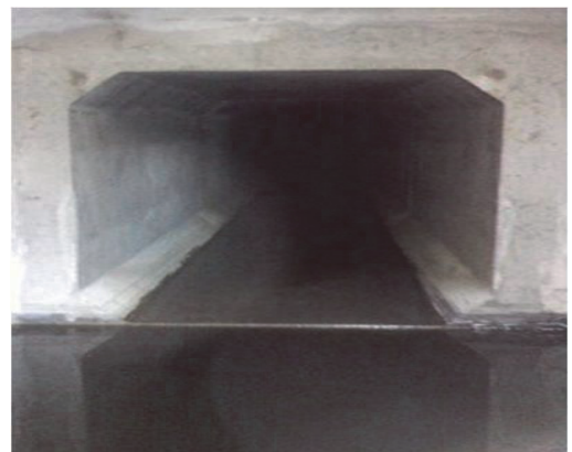
(※6) 茨城県石岡市 BOX 800×800×2000mm (TB工法)
