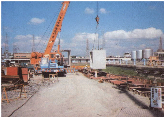
搬入及び施工
