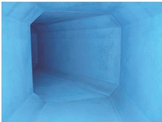
(※3) 宮城県白石市 BOX 700×700×2000mm (TB工法)
