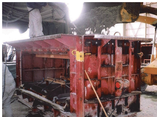
コンクリート打込み
