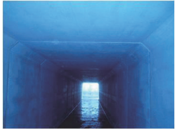
(※2) 宮城県栗原市 BOX 2500×2500×2000mm (PC鋼棒による縦締め連結工法)
