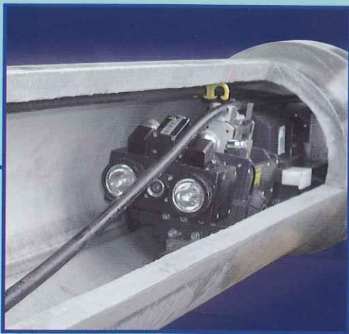
ロボットによる光ファイバーケーブル装着作業
