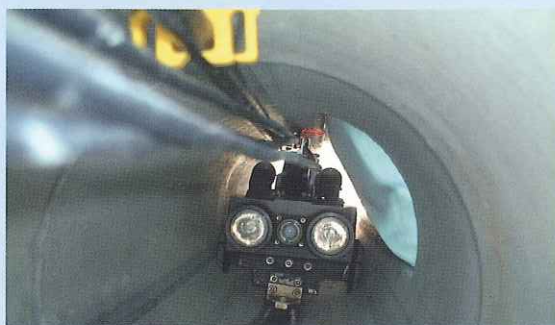
装着ロボットによる取付管用引込ケーブルの装着作業
