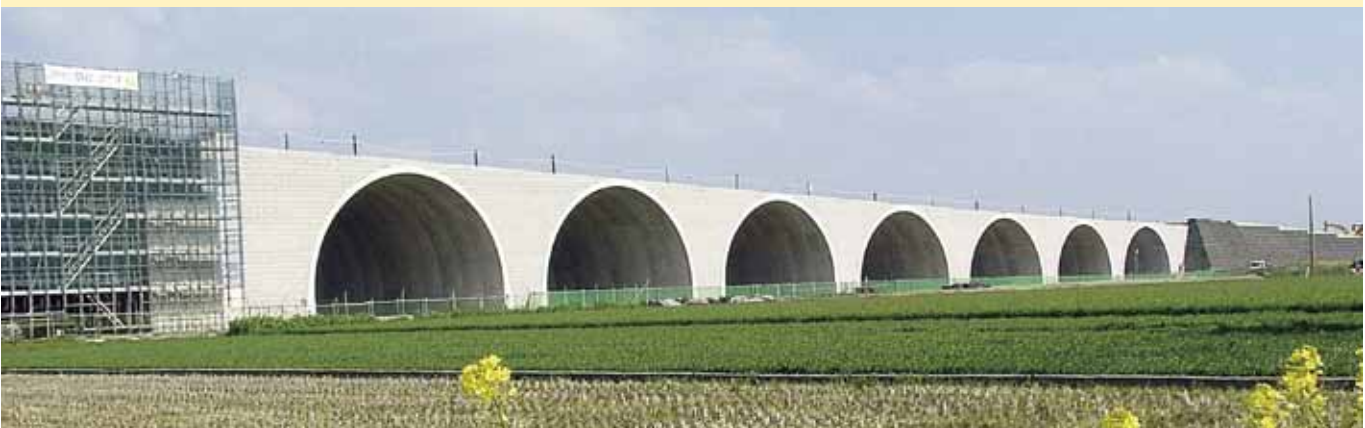
国土交通省福岡国道事務所（福岡県） 91/145、64/110、52/110
