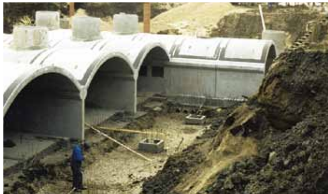
地下貯留施設 (デンマーク) 5 \times S7.5m^2 / V25m^3
