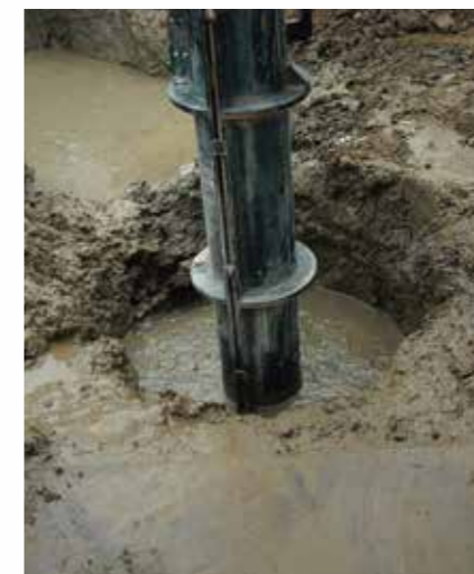
①掘削孔に装置挿入
