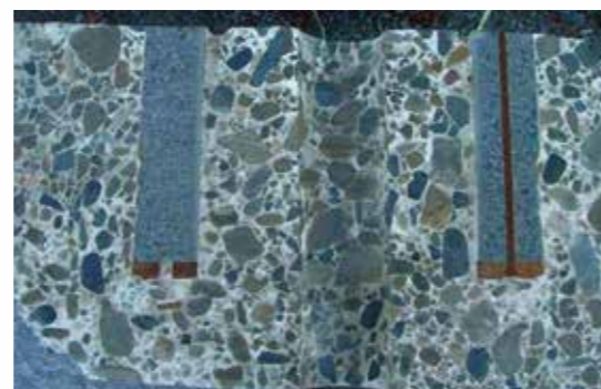
切断状況(全体)
