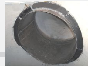
4. ステンスカラーの周囲に耐震ゴムリングと目地用弾性体を挿入します。
