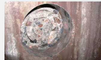
▲削孔完了状況
