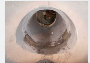
2. 耐震ゴムリング設置、挿入に必要な幅だけ既設管、インパートを切削除去します。
