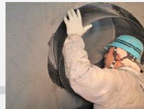
3. 既設管切削除去部にステンスカラーを装着します。
