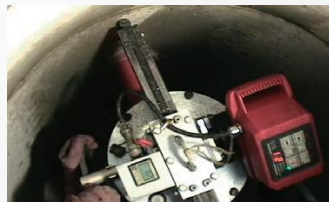
▲マンホール壁の削孔状況
