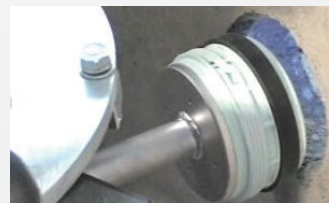
▲消散弁の圧入状況
