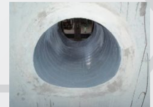
5. 管きよ更生工事を施工します。
