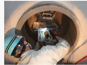
4. ステンスカラーの周囲に耐震ゴムリングと目地用弾性体を挿入します。
