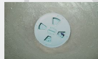
▲施工完了状況
