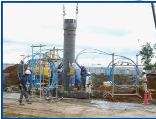
杭外周部へのUチューブの取付け
