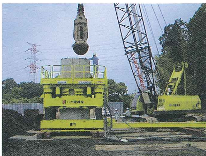
PCウエル施工状況
