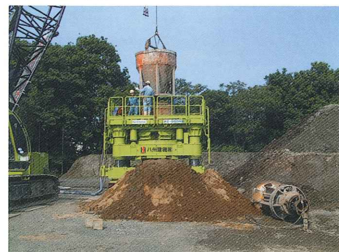
場所打ち杭施工状況
