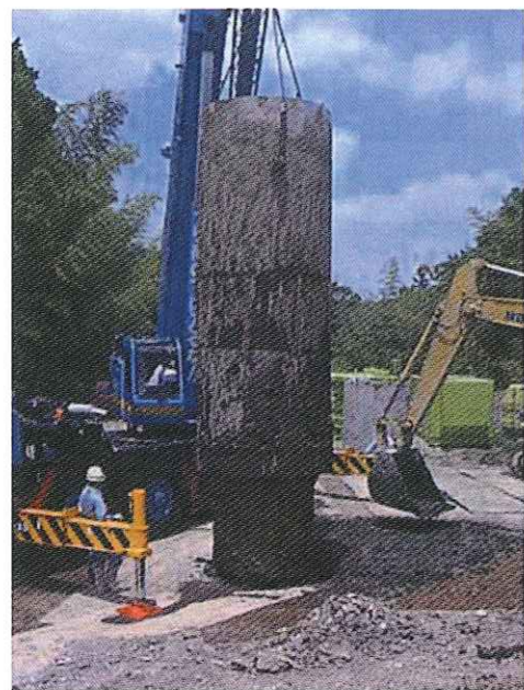
試験体引抜き状況
