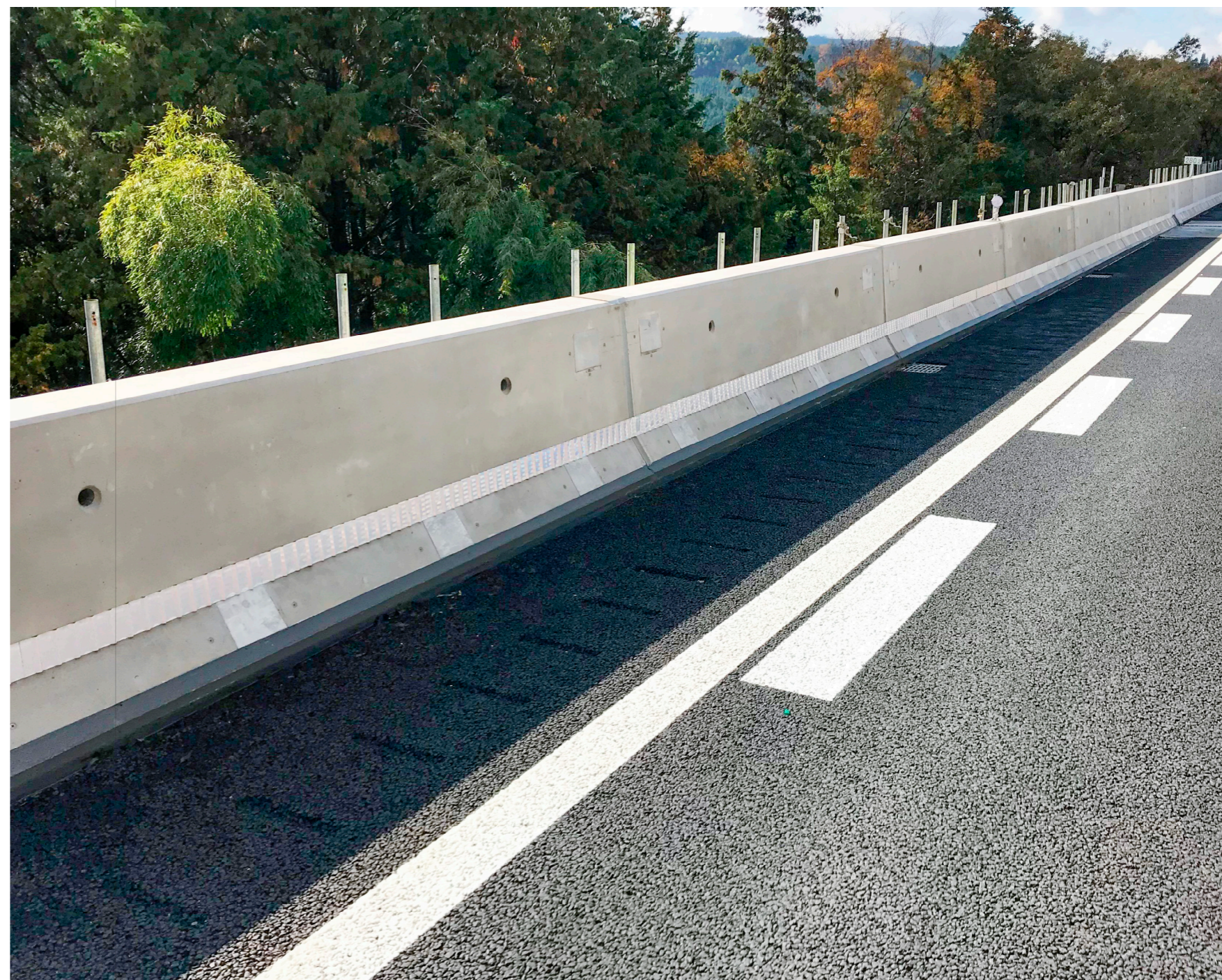
中央自動車道 松ヶ平橋
