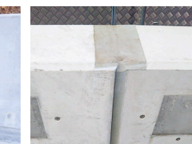
目地部シーリング
