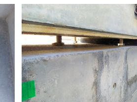
高さ調整用ボルト・底面モルタル施工目地材
