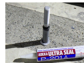
床版のアンカーボルト設置
