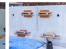
箱埋めモルタル型枠
