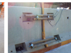
断面モルタル型枠
