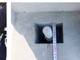
アンカーボルト孔への納まり
