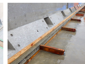
底面モルタル型枠
