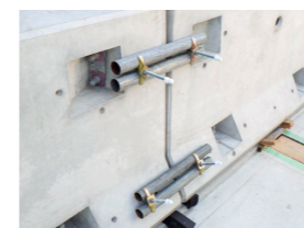
単管パイプによる位置調整
