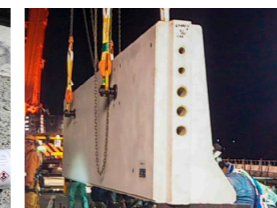
壁高欄本体の吊上
