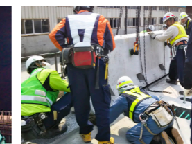
壁高欄本体の設置
