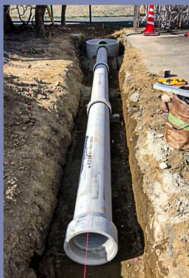
ヒューム管、組立マンホール
