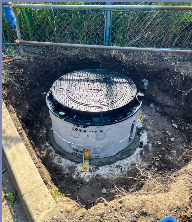
組立マンホール
