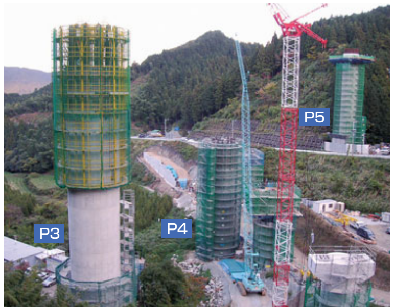
昇降式移動型枠施工<P3> 施工中のP2橋脚からのぞむ
