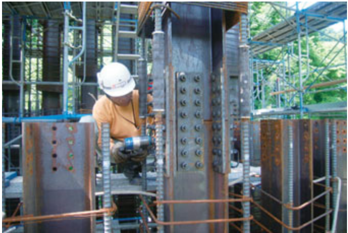
スパイラルカラムの接合1
