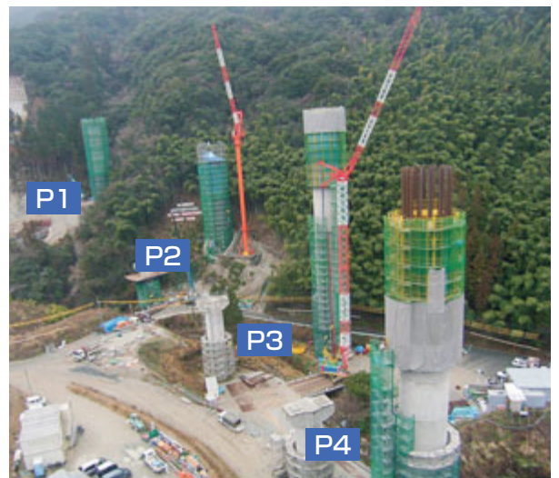
施工状況全景
