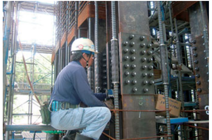
スパイラルカラムの接合2
