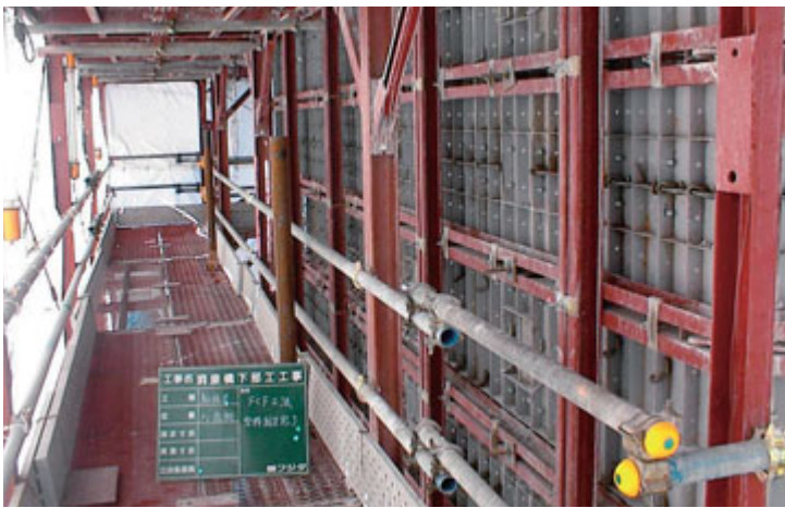
外側型枠支保工状況
