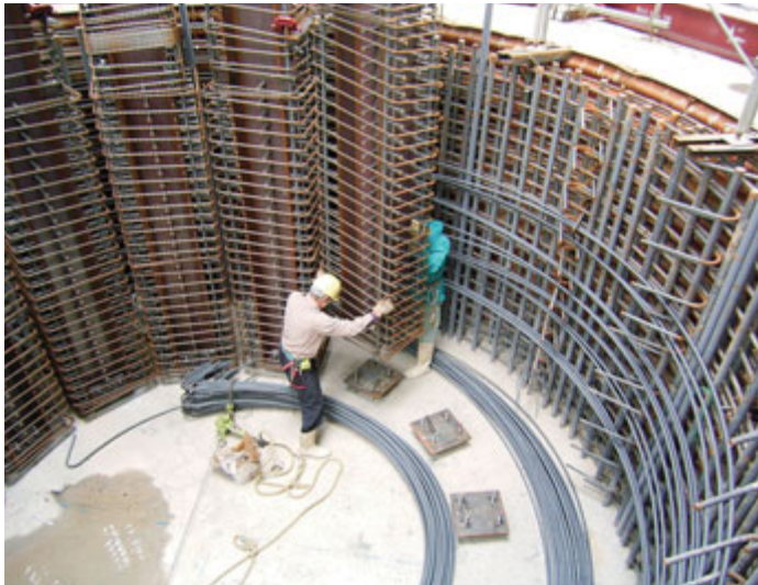
深礎杭基礎と定着部
