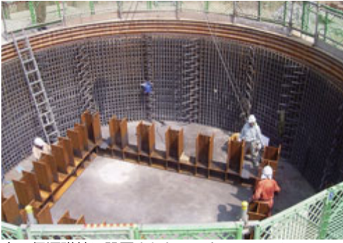
大口径深礎杭に設置されたアンカーフレーム
