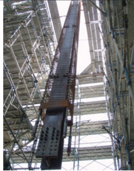
スパイラルカラムの建込み2
