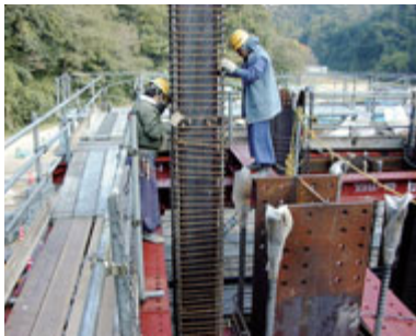
スパイラルカラム建込み
