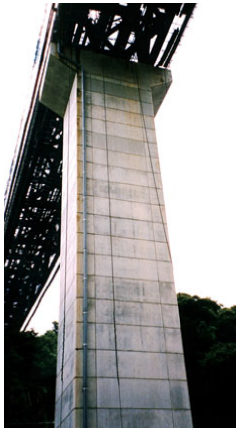
完成橋脚〈P3〉
