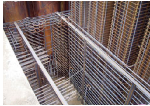
スパイラルカラム第1ロット建込み完了
