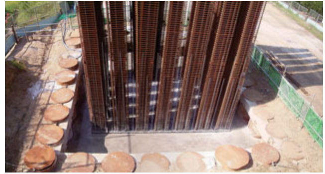
フーチングコンクリート打設完了
