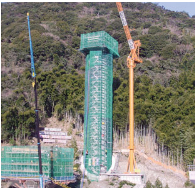
総足場施工<P2>
