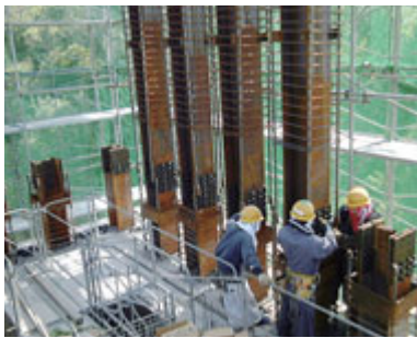
スパイラルカラム建込み
