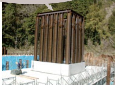
第一ロット建込み完了
