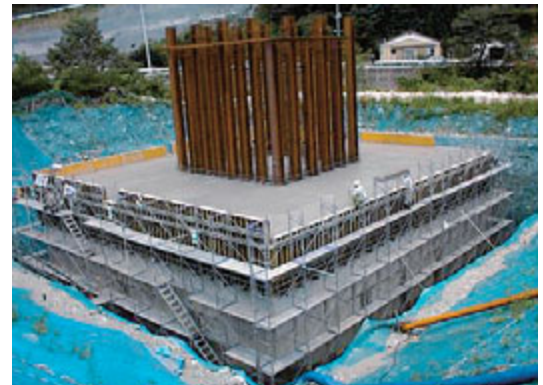
第1ロット建込み完了(直接基礎)<P2>
