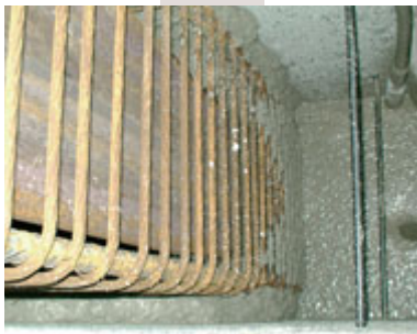
二次コンクリート打設
