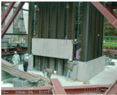
3Hパネル据え付け
