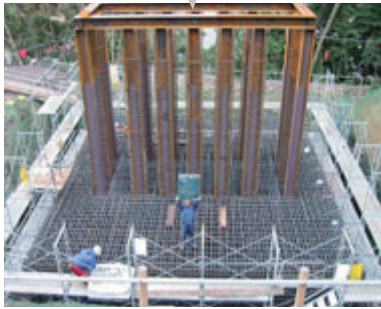
第1ロット建込み完了
