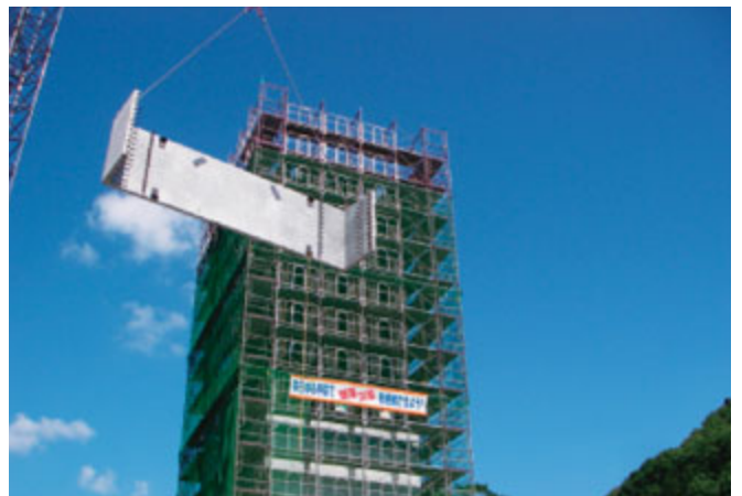
3Hパネル吊り込み状況
