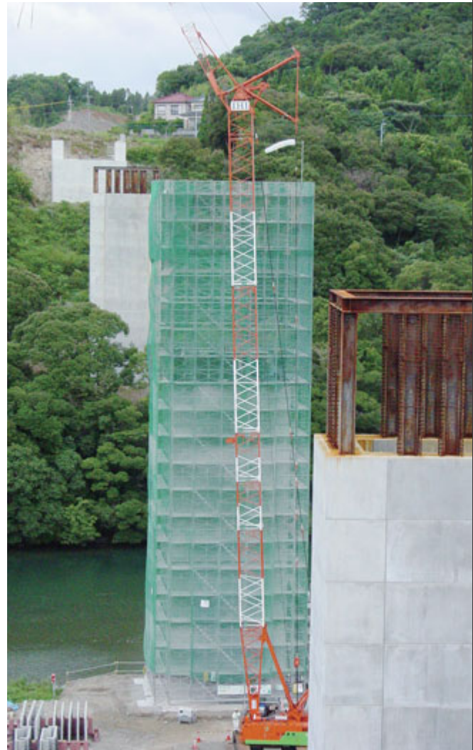
施工状況全景
