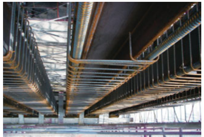
スパイラルコラム施工状況
