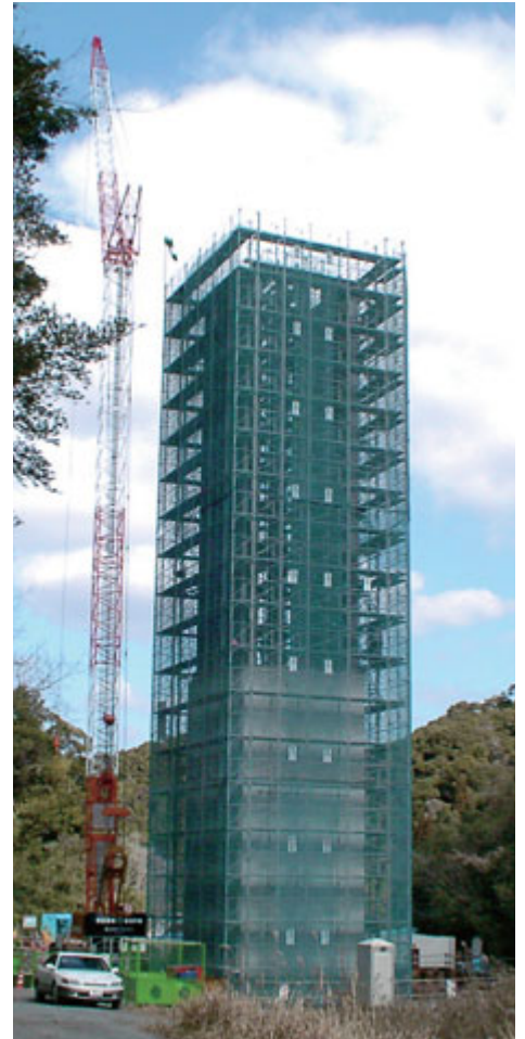
施工状況全景
