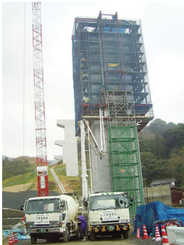
コンクリート打設状況
