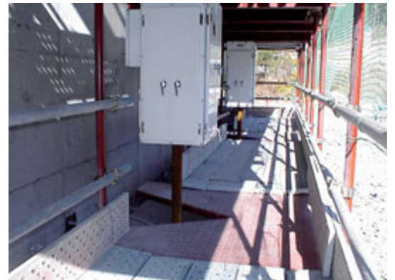
昇降式移動型枠
