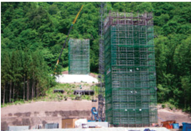
施工状況 (P1奥、P2手前)
