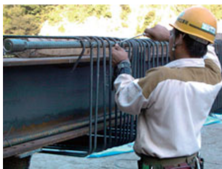
スパイラルカラムの地組みの状況
