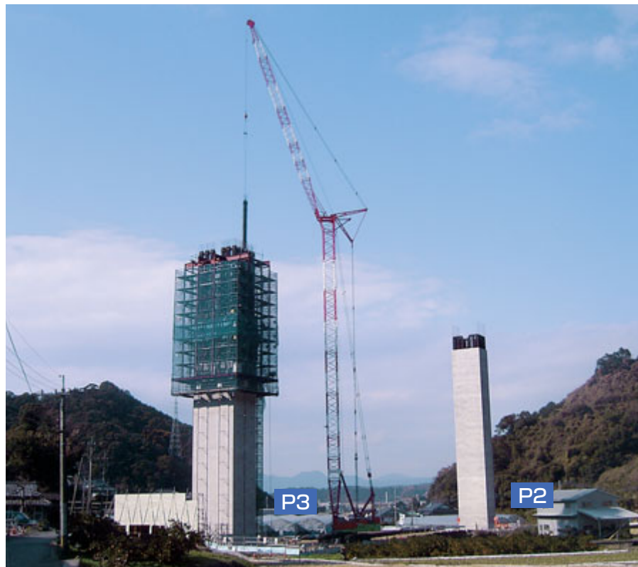
施工状況全景
