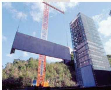
3Hパネル吊り込み
