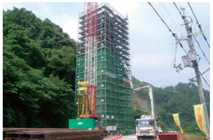
コンクリート打設
