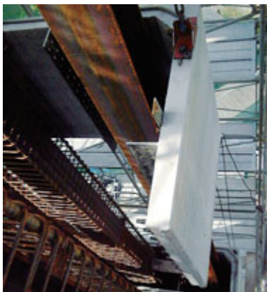
3Hパネル吊り込み
