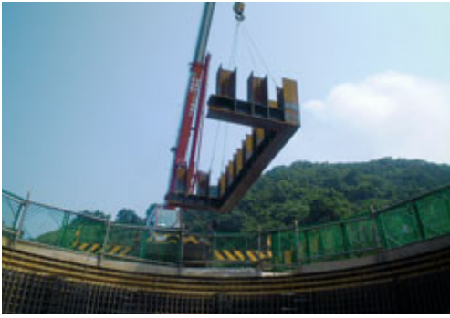
アンカーフレームの建込み
