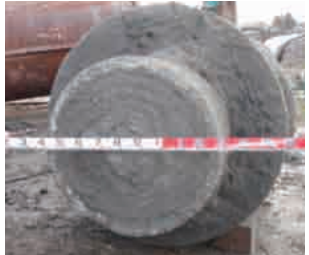
根固め部掘出し
