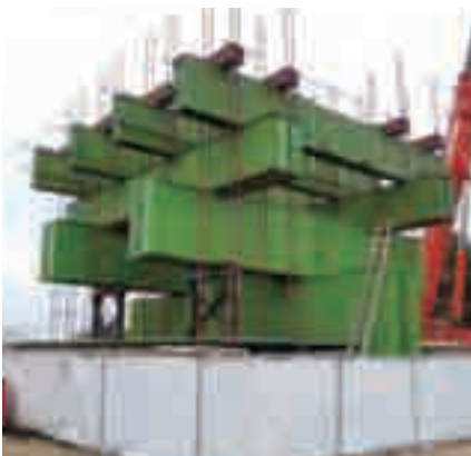
鉛直載荷試験
