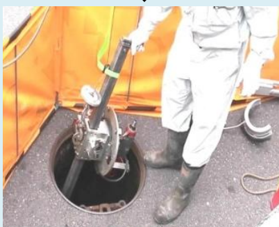
60cmの開口部より施工機械を搬入
