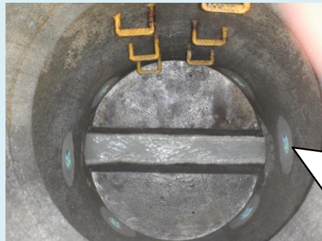
消散弁の人孔壁面への設置状況
