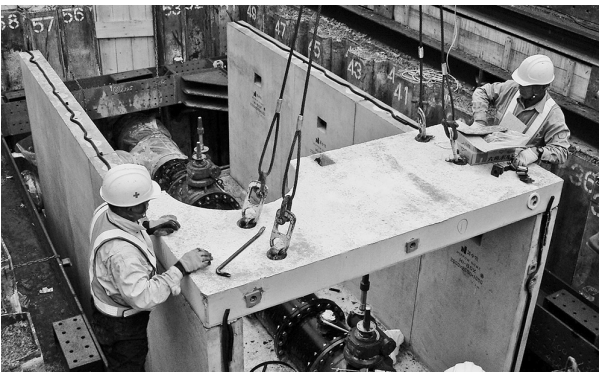
北海道で700基以上の実績をもつ地域限定製品を改良(写真は施工の様子)
