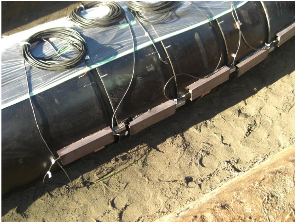
(参) 写真-25 管軸方向変位計カバー設置
