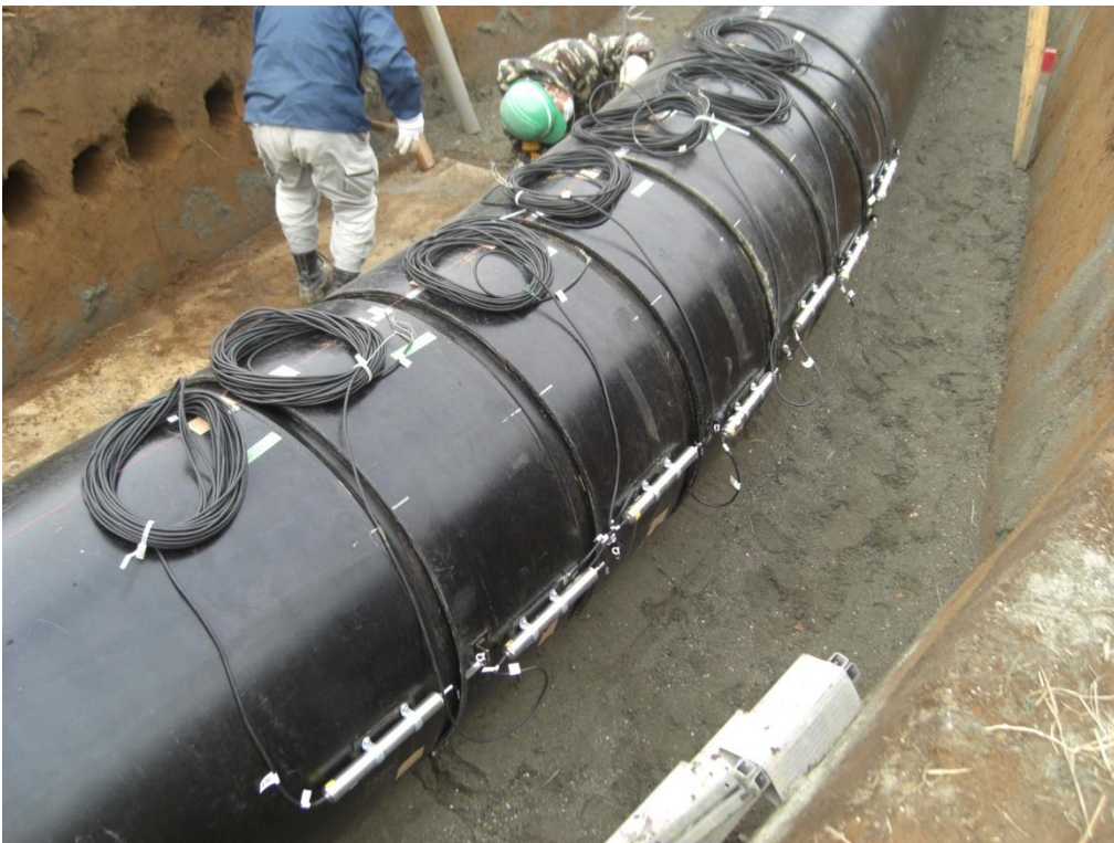
(参)写真-14 変位計設置 (曲線部)
