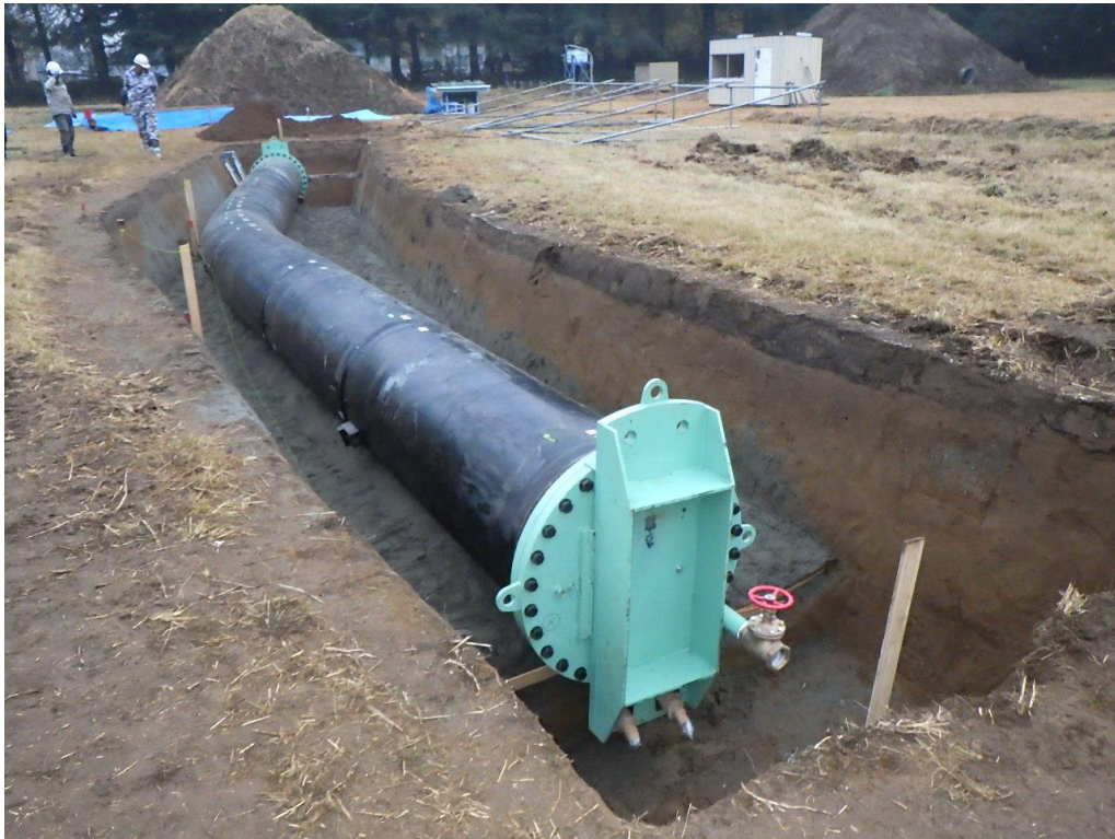
(参)写真-7 端版取付け完了
