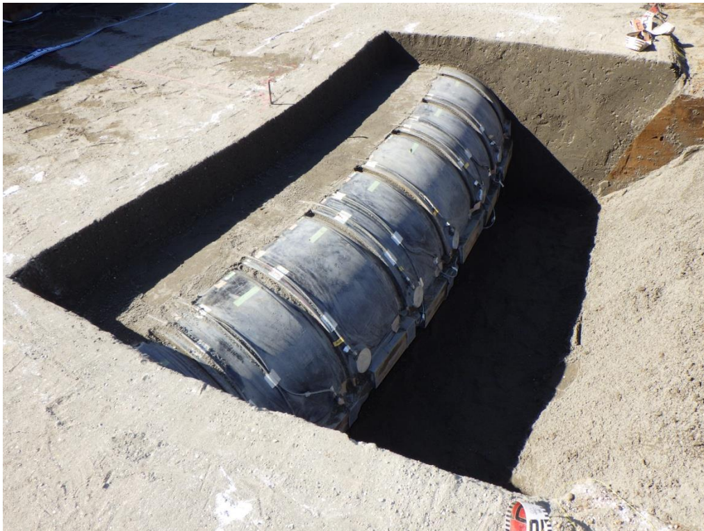
(参)写真-73 実験 CASE 7 (土被り 0.2m) 背面抵抗土圧なし-管上埋戻し土撤去
