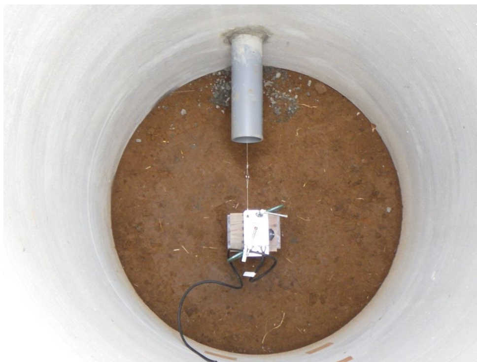
写真3. 3 ワイヤ式変位計設置（水平方向）
