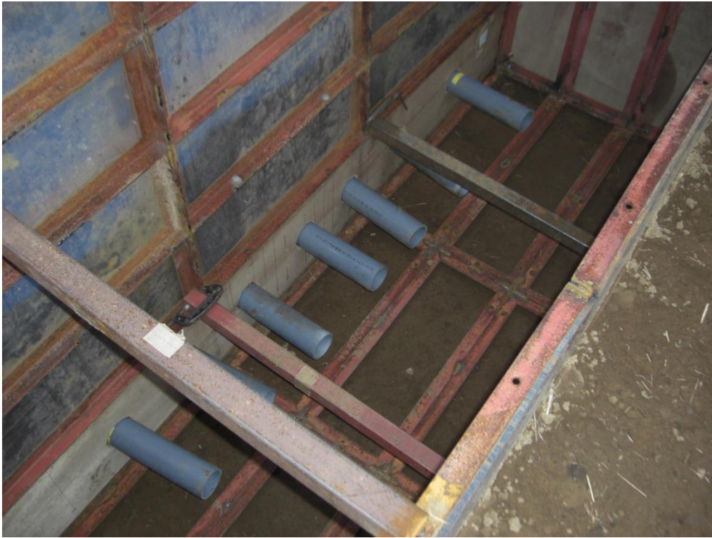
(参) 写真-21 ワイヤー型変位計設置孔
