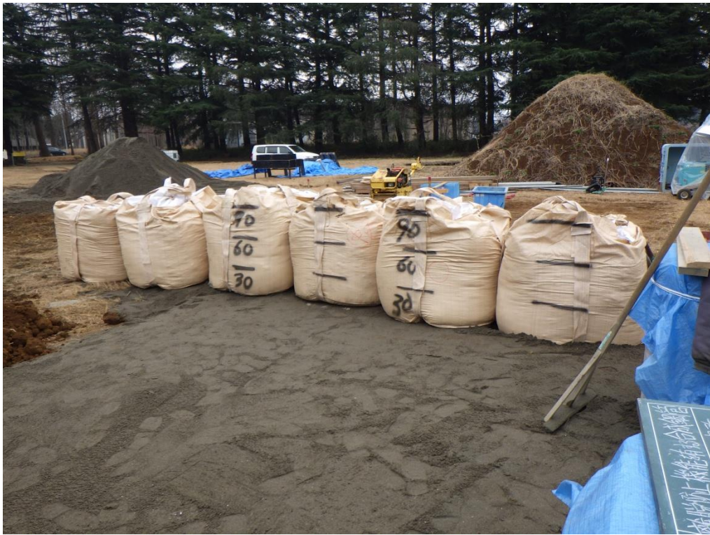
(参)写真-46 フレコンバッグ設置完了
