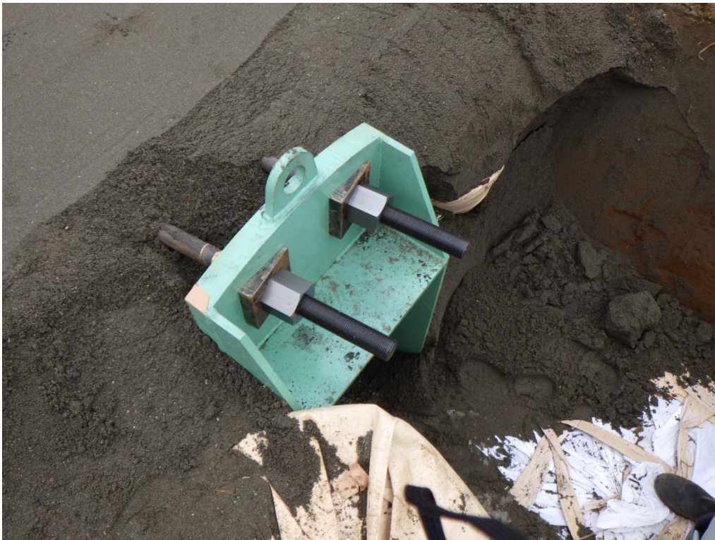
(参)写真-38 上部 PC 鋼棒据付け
