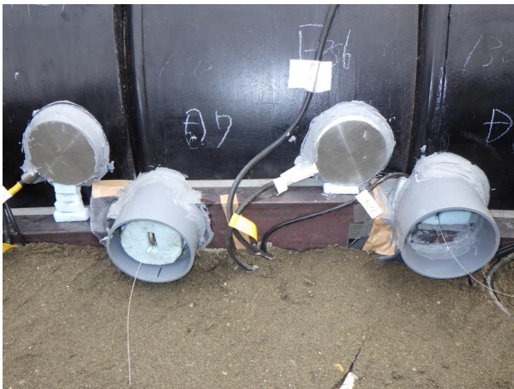
(参) 写真-33 土圧計設置
