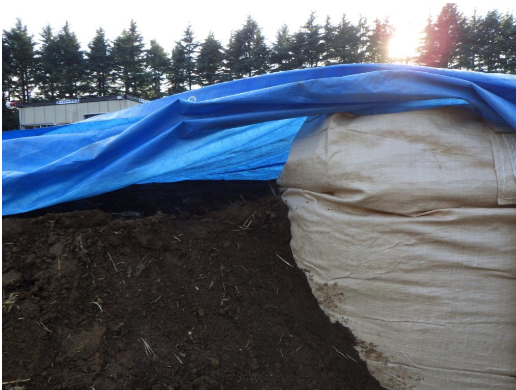
(参)写真-61 実験 CASE 2 (土被り 0.6m) 雨水対策シート
