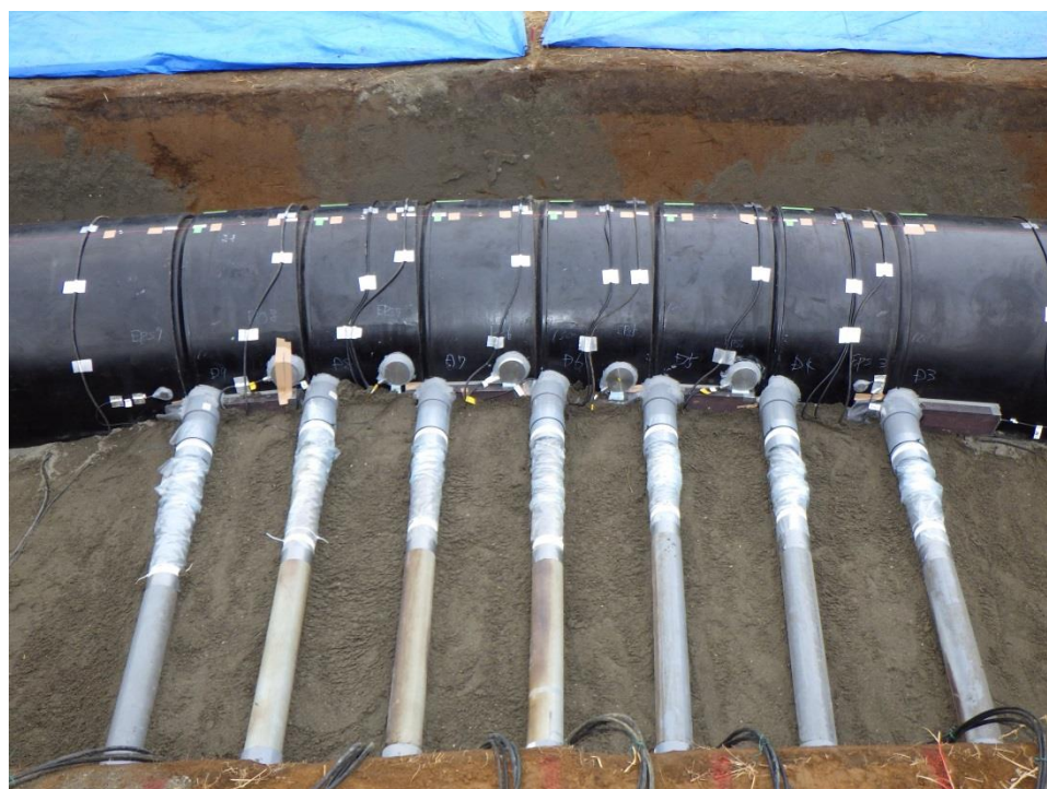
写真3. 4 ワイヤ式変位計設置（水平方向）
