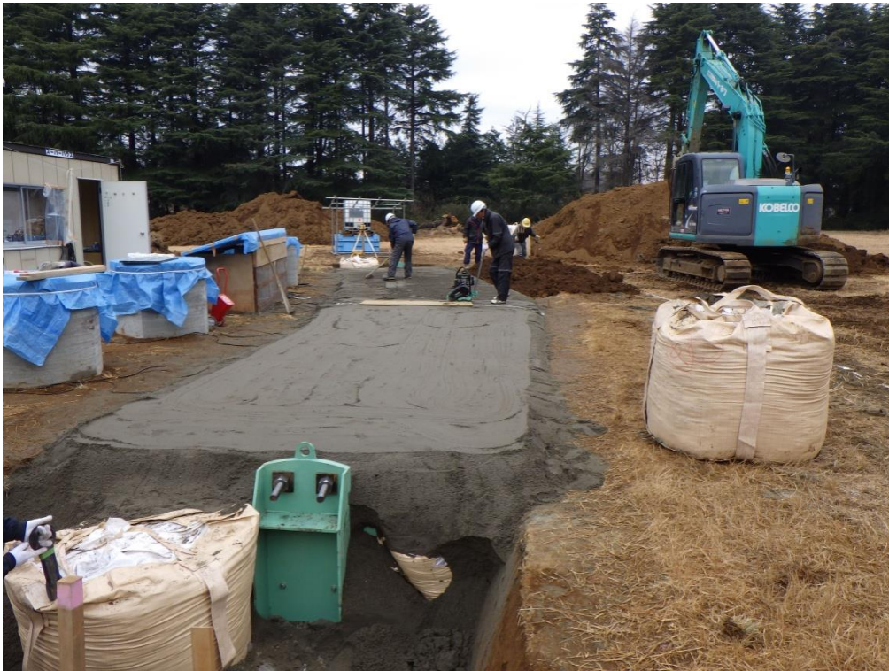
(参)写真-39 砂敷き均し
