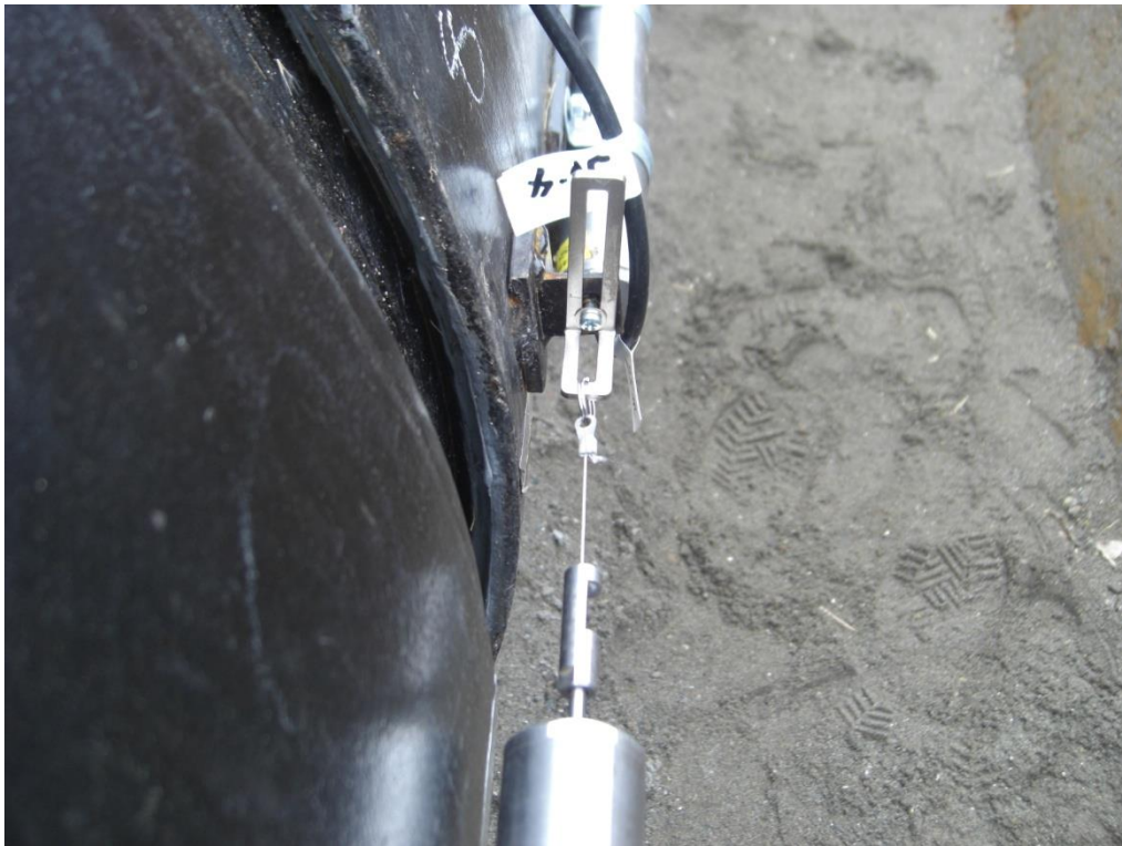
(参)写真-19 管軸方向変位計
