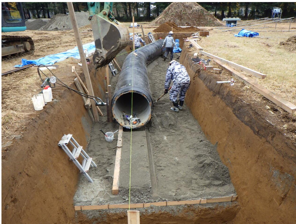
(参)写真-2 管体位置出し
