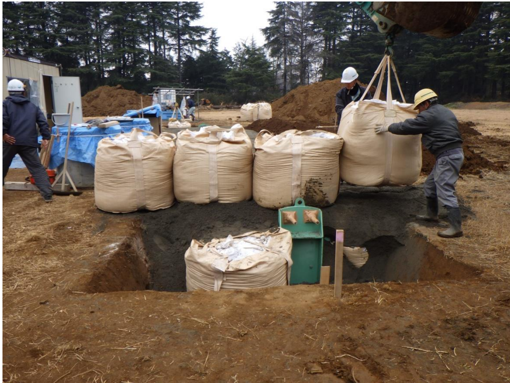
(参)写真-43 フレコンバッグ設置
