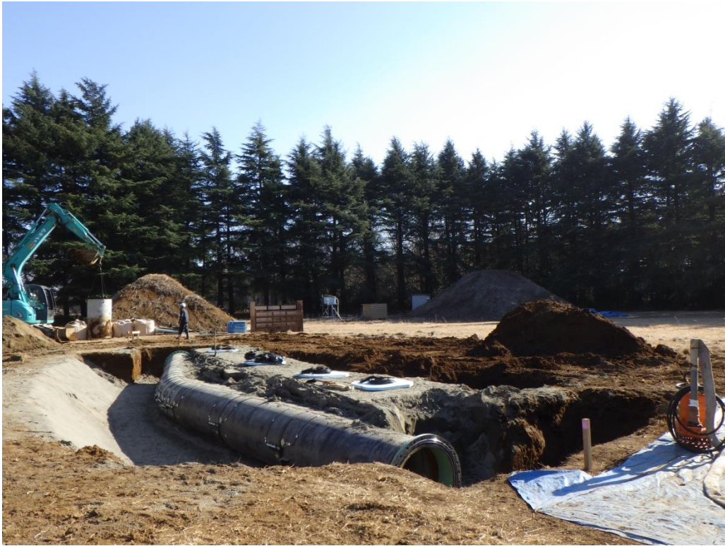
(参)写真-81 管路撤去作業
