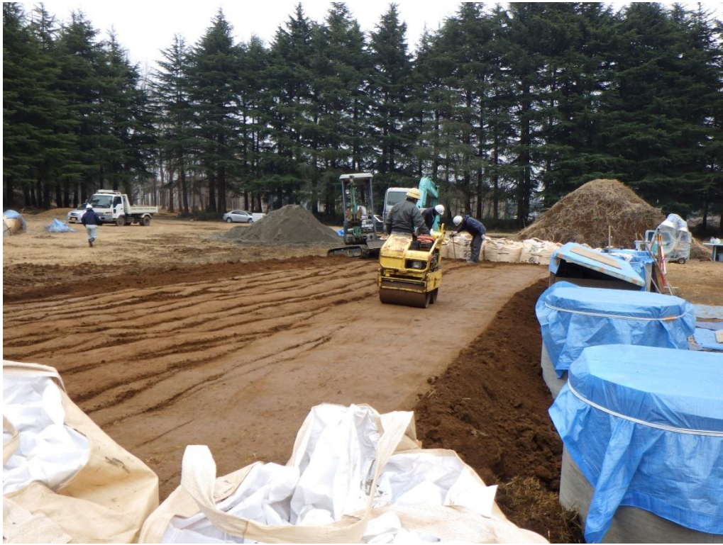
(参)写真-49 盛土敷き均し
