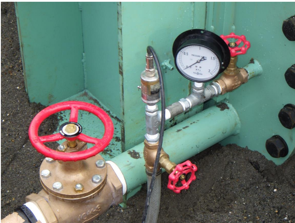
(参) 写真-56 圧力計測機器設置
