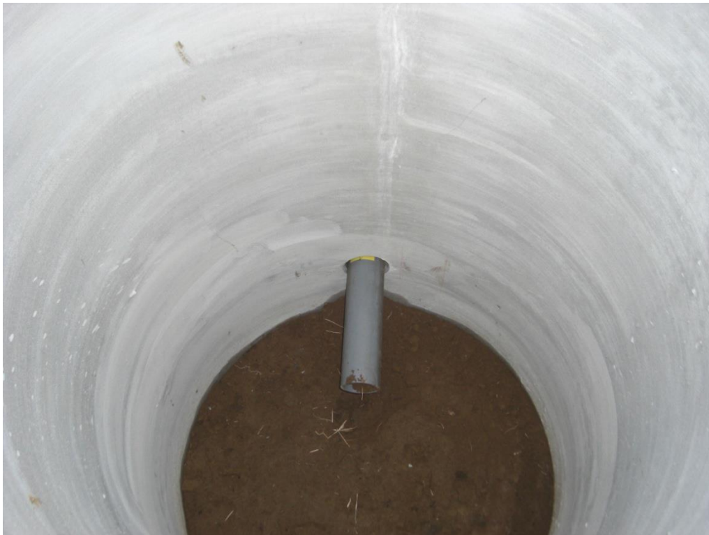
(参) 写真-22 ワイヤー型変位計設置孔
