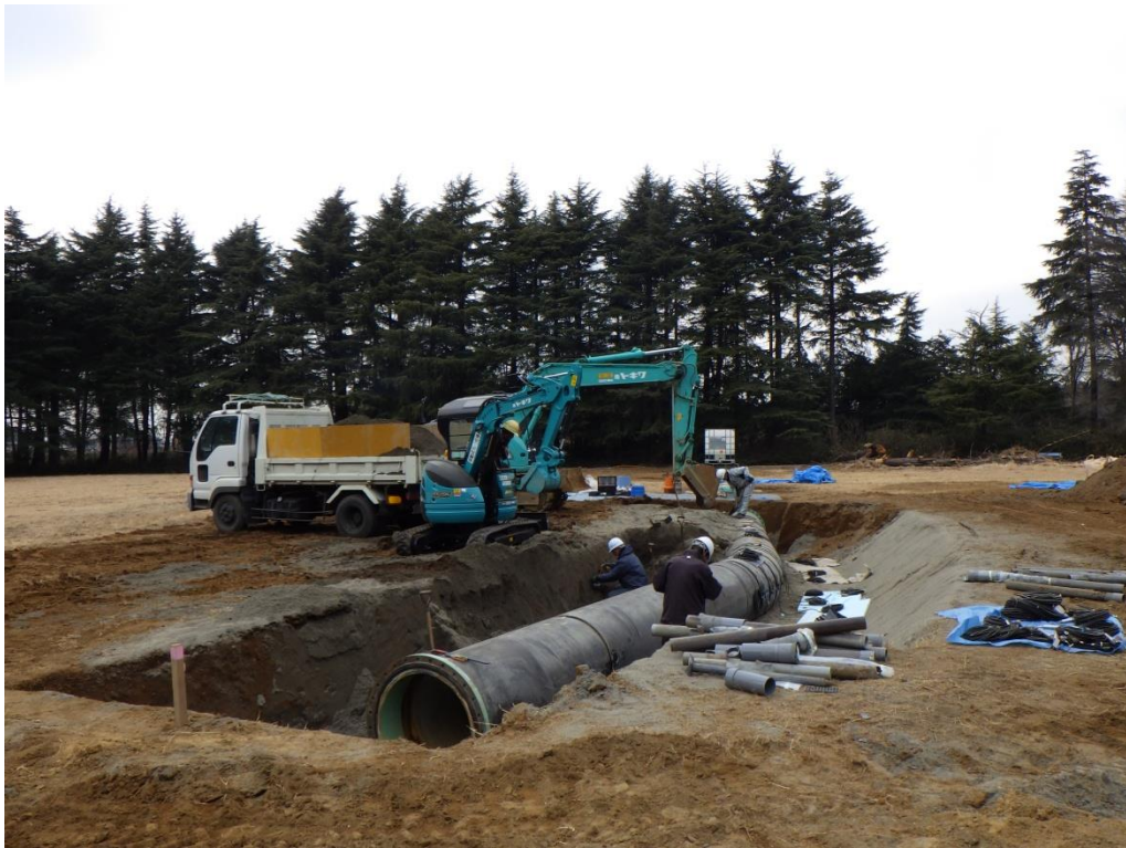
(参)写真-82 管路撤去作業
