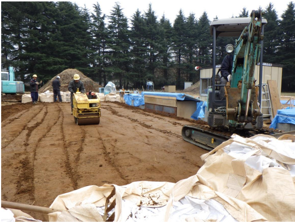
(参)写真-50 盛土敷き均し
