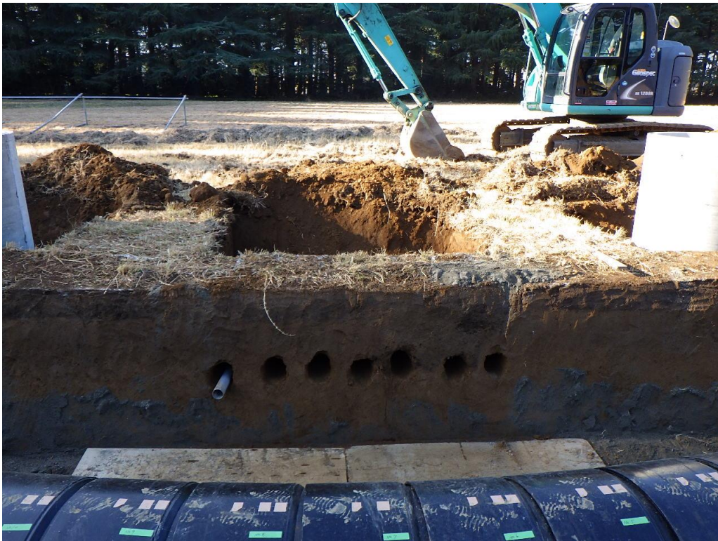
(参)写真-10 計測器設置準備
