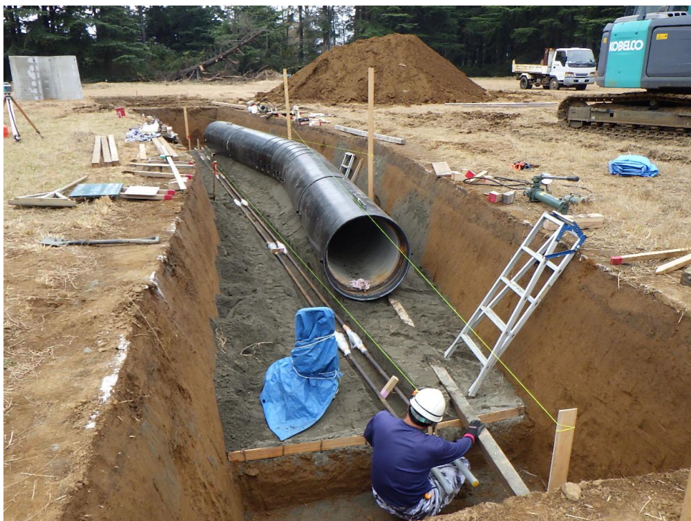
(参)写真-3 PC 鋼棒据え付け
