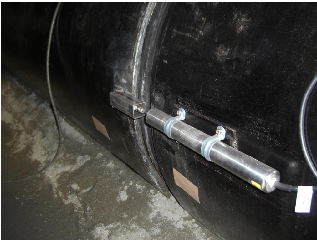
(参)写真-24 管軸方向変位計設置
