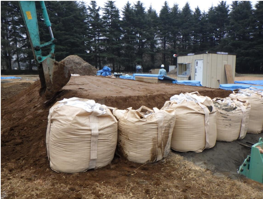
(参)写真-51 盛土敷き均し完了
