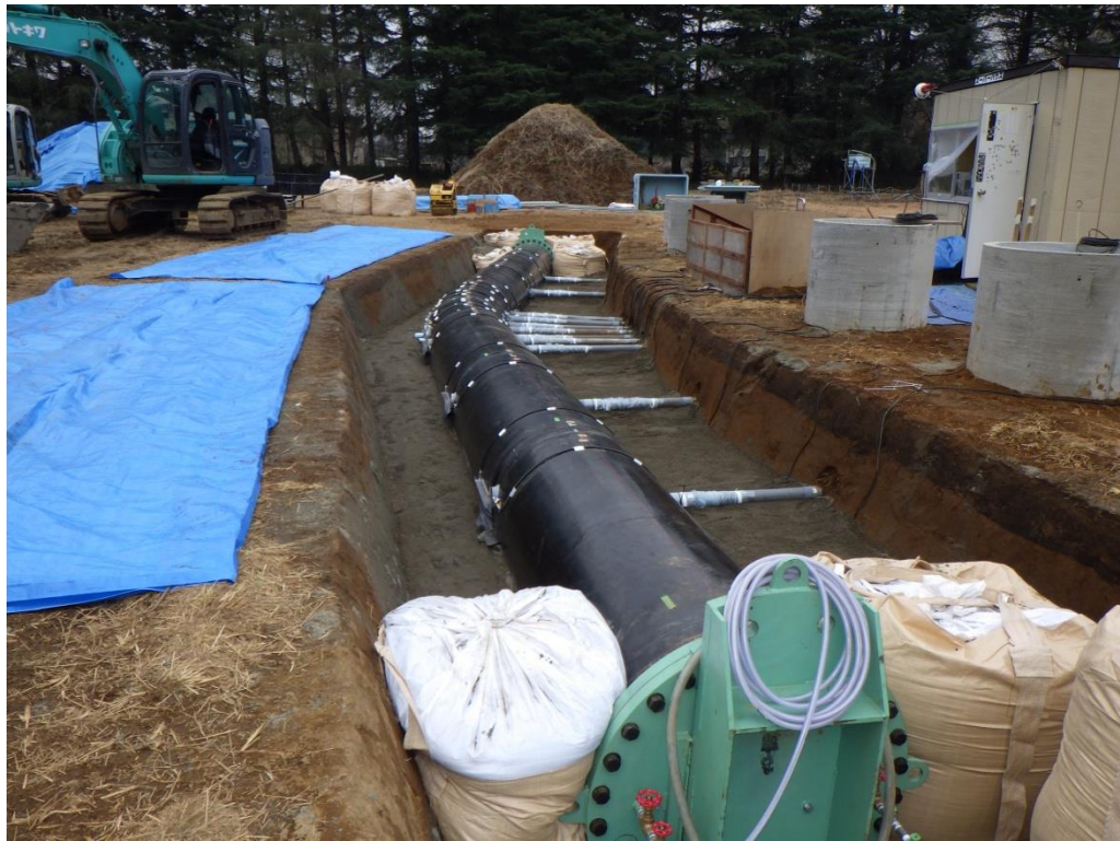
(参) 写真-36 ワイヤー型変位計設置完了
