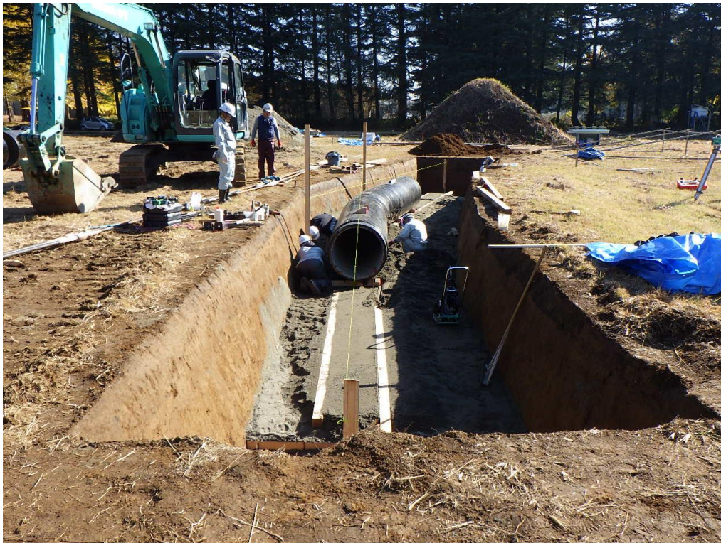
(参)写真-1 管路敷設位置出し
