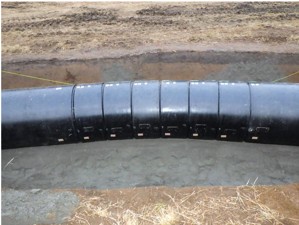
(参)写真-8 管路曲線部
