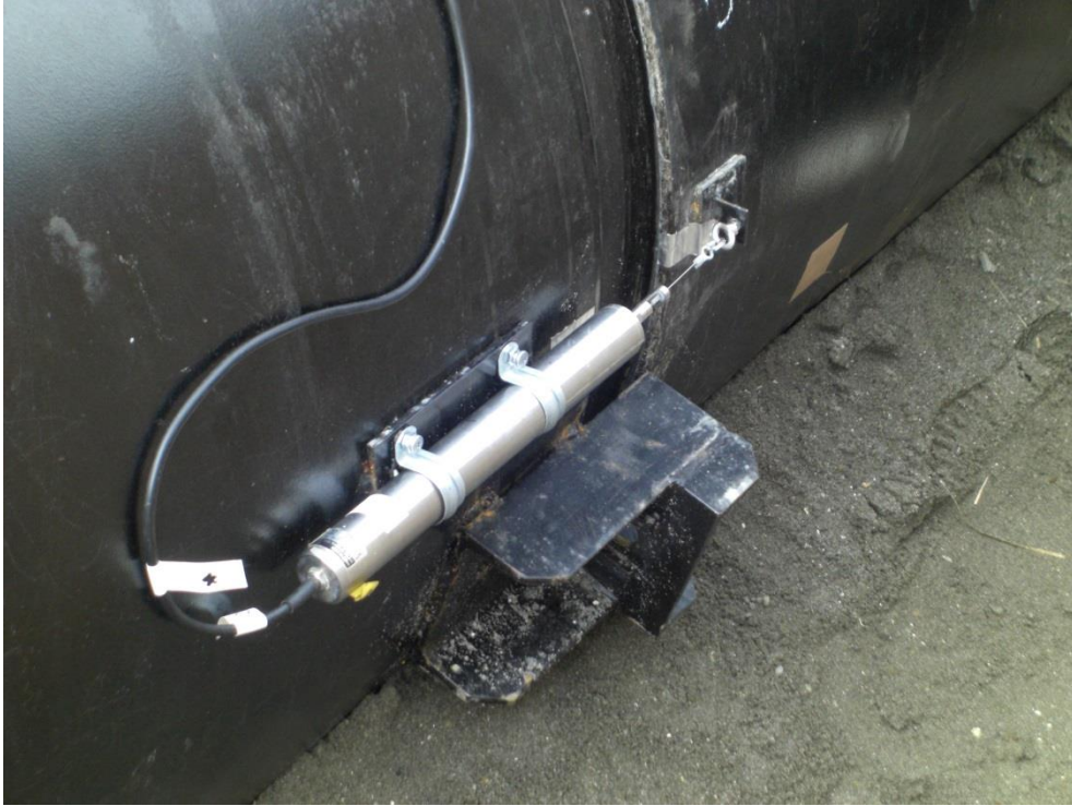
写真 3. 2 防水型変位計設置状況
