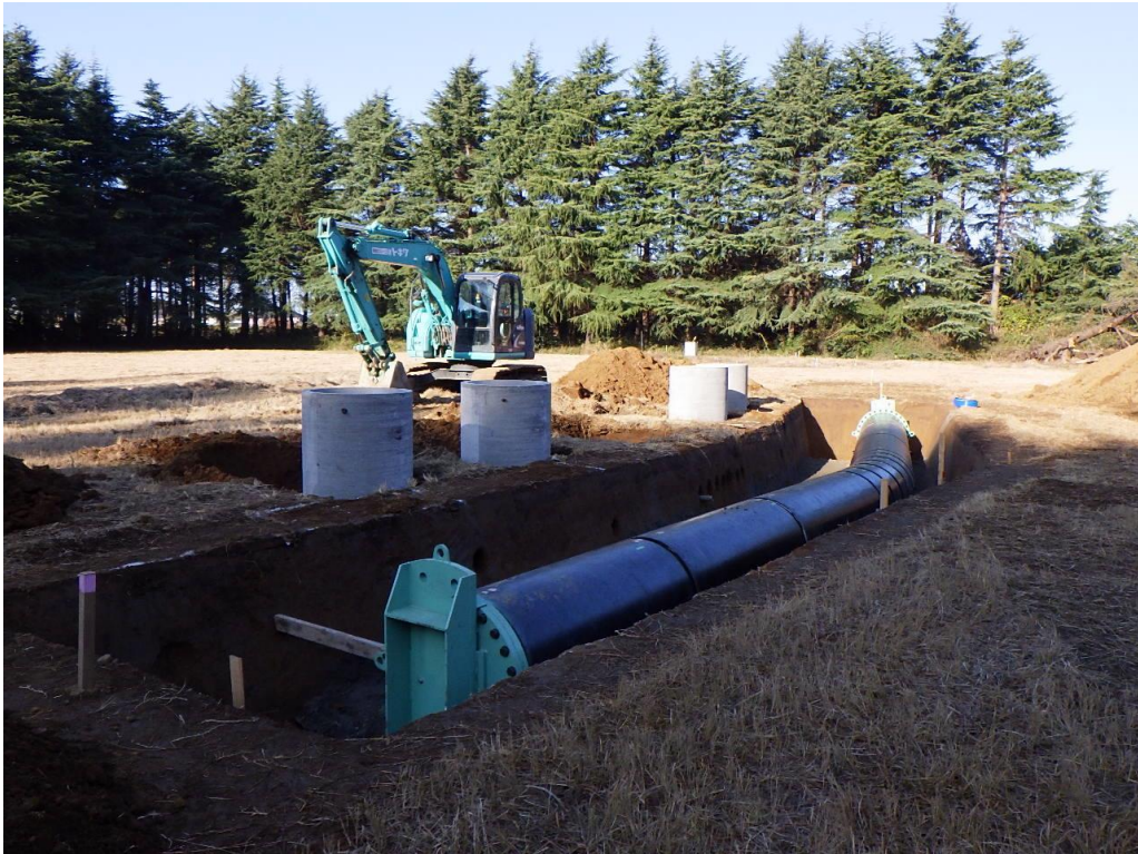
(参)写真-9 管路完成
