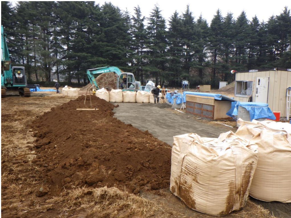
(参)写真-44 フレコンバッグ設置
