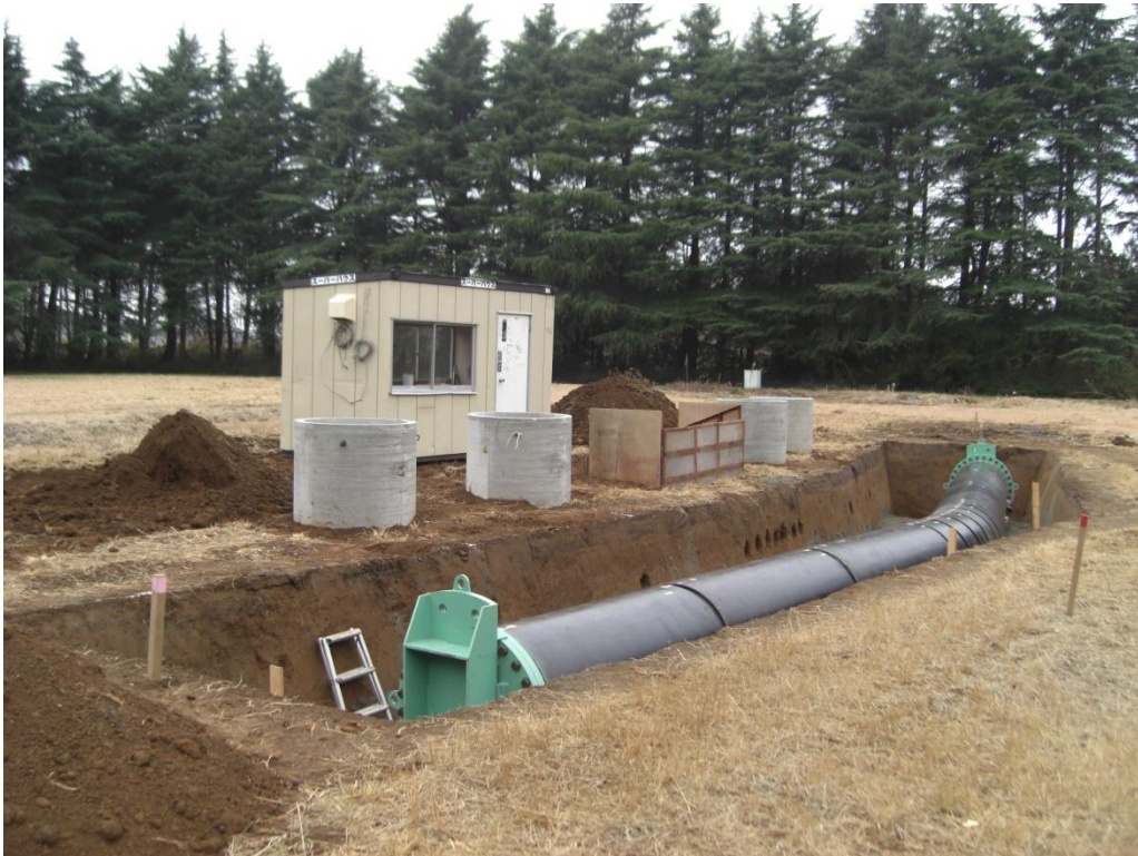
(参) 写真-11 変位計取付マンホール設置
