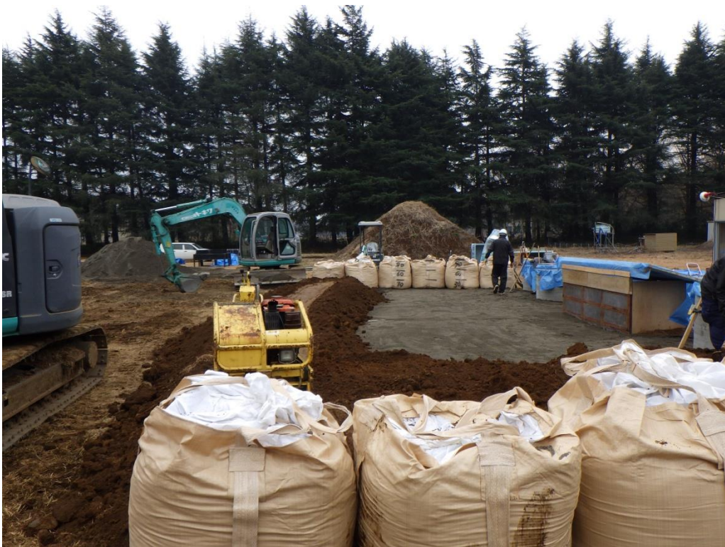
(参)写真-48 土盛作業
