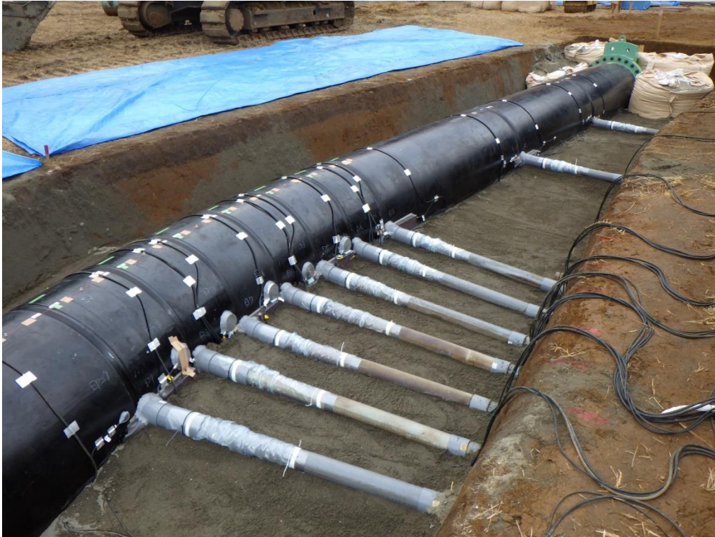
(参) 写真-35 ワイヤー型変位計設置完了
