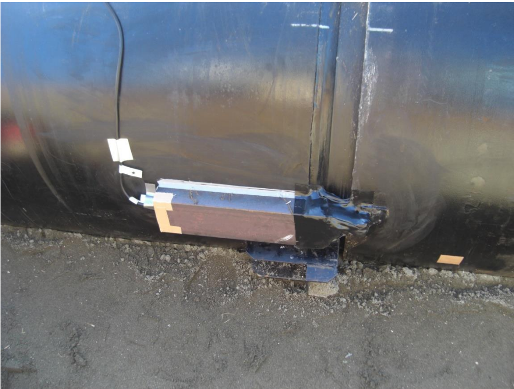
(参)写真-28 管軸方向変位計設置完了
