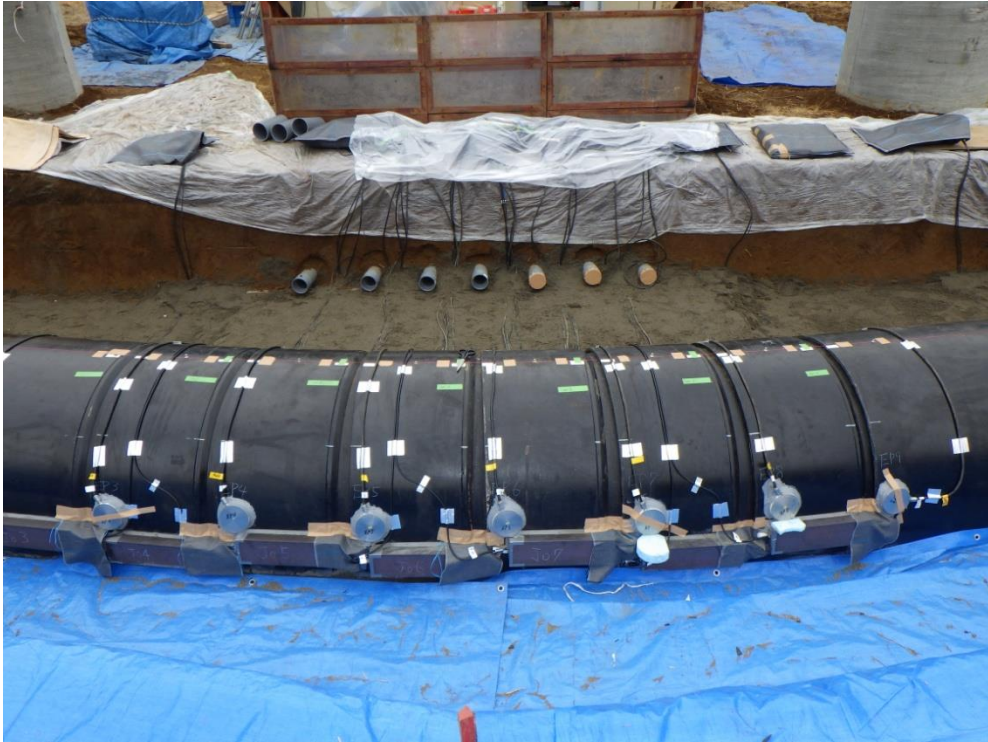
写真 3. 6 土圧計設置状況
