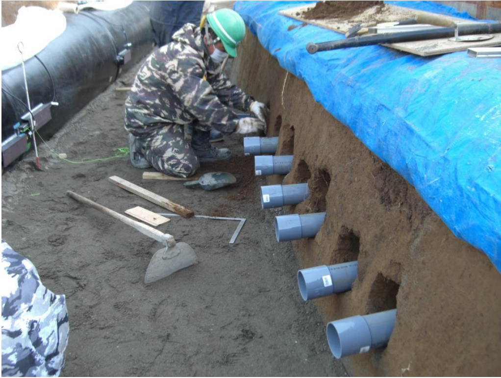
(参)写真-29 ワイヤ型変位計設置孔パイプ
