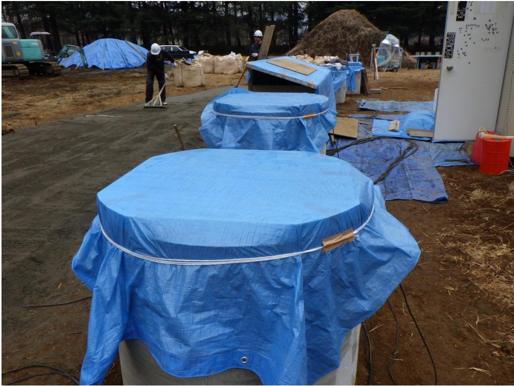
(参) 写真-41 雨水対策シート
