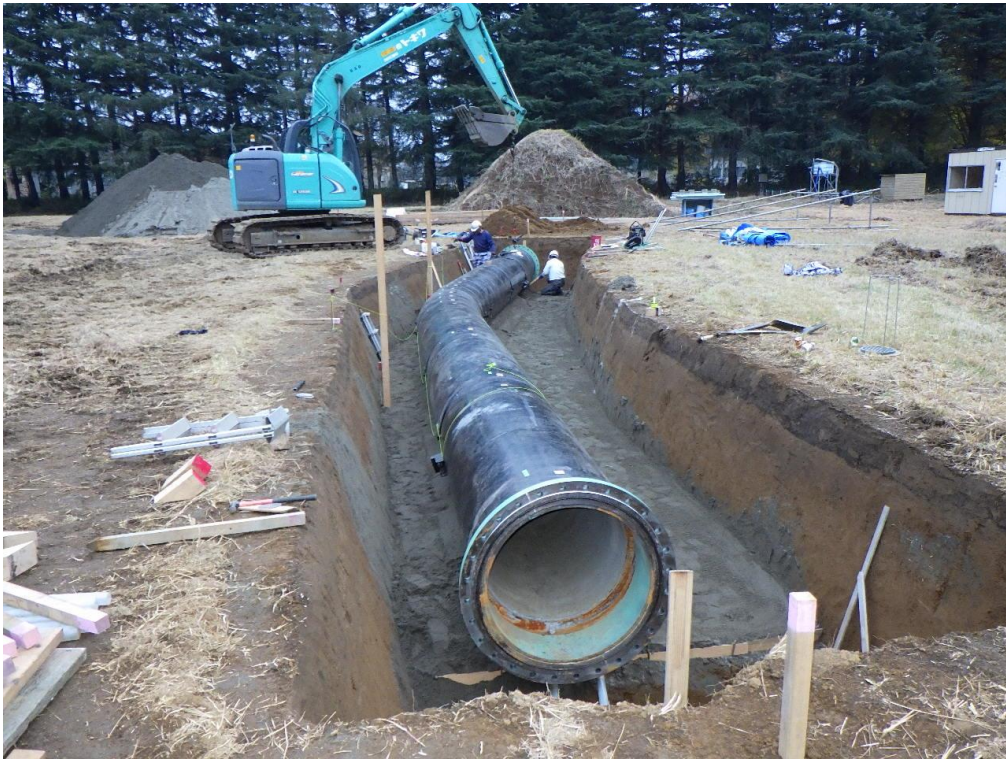
(参)写真-5 管体据え付け完了
