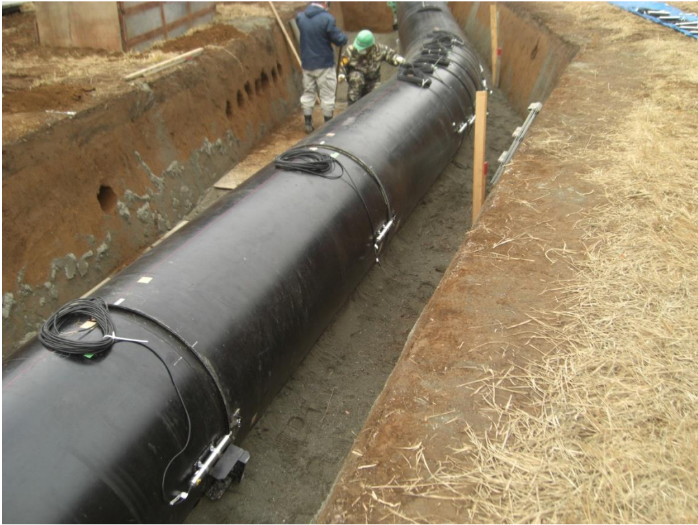
(参)写真-15 変位計設置 (直線部)
