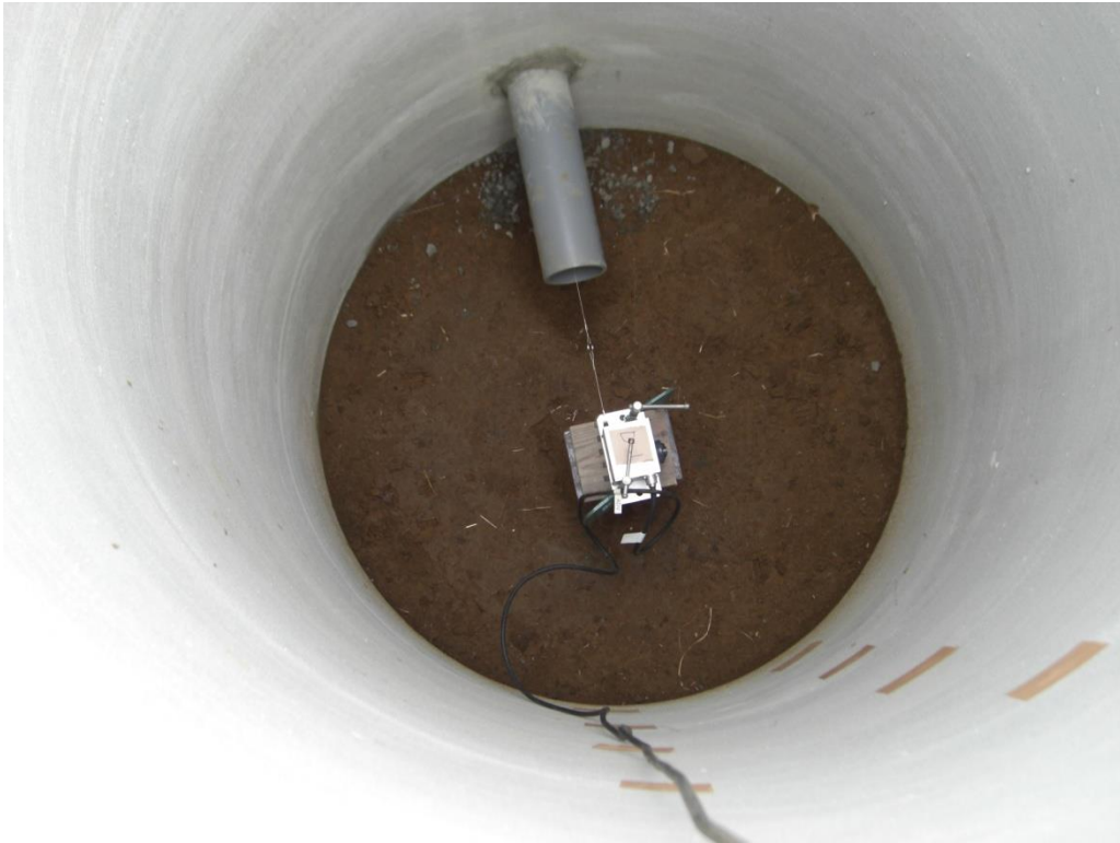
(参)写真-31 ワイヤ型変位計設置
