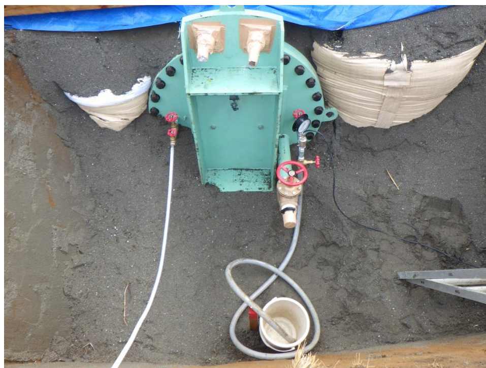
写真3.8 内水圧負荷装置設置状況
