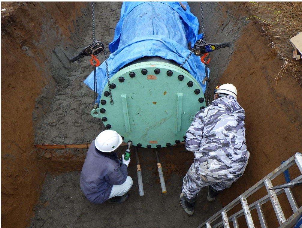
(参)写真-6 端版取付け
