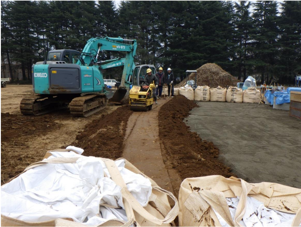
(参)写真-47 土盛作業
