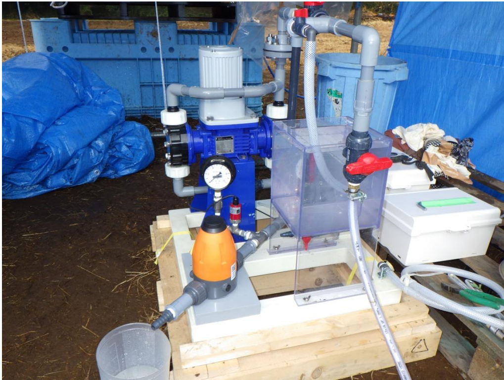
(参) 写真-57 水圧ポンプ設置
