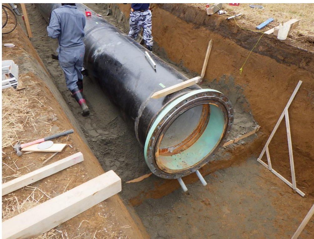
(参)写真-4 下部 PC 鋼棒据え付け完了
