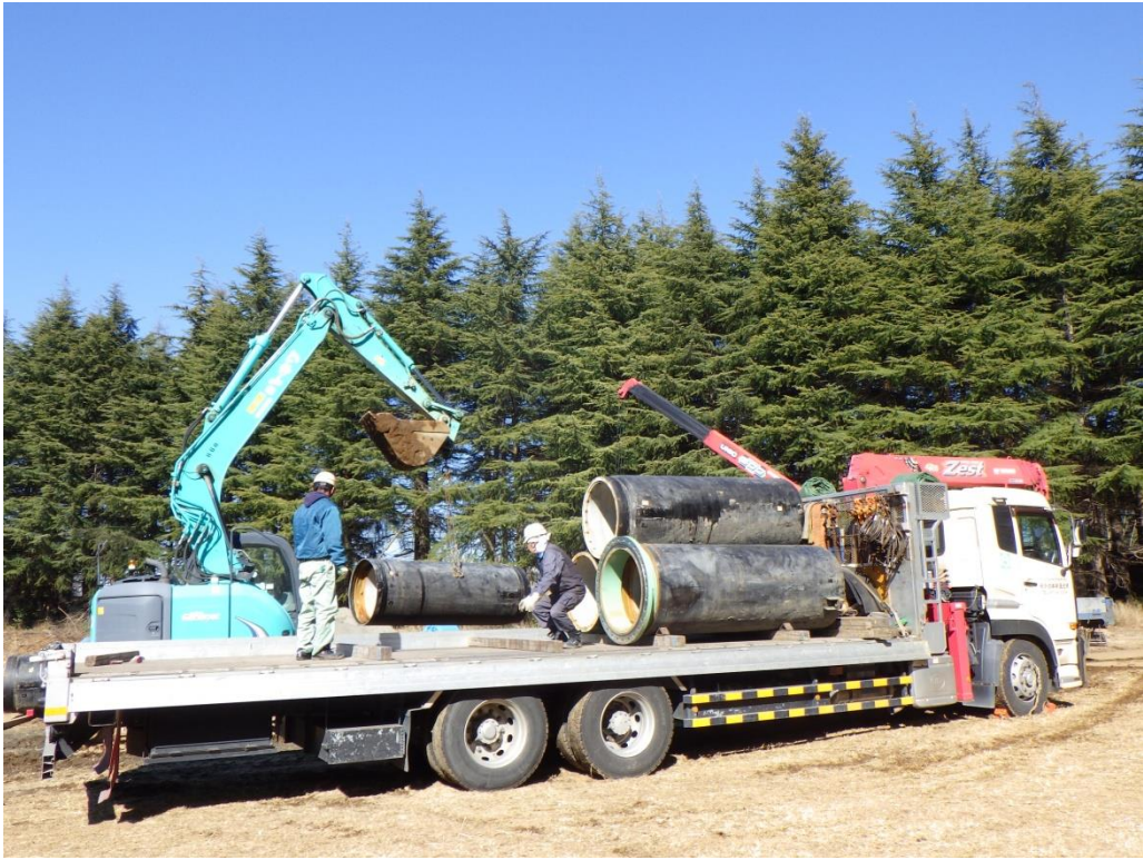
(参)写真-83 管路撤去
