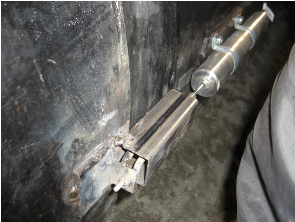
(参)写真-23 管軸方向変位計設置
