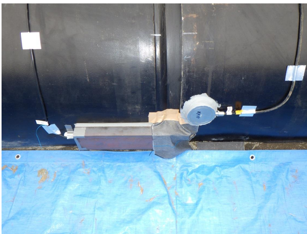
写真3. 5 土圧計設置状況
