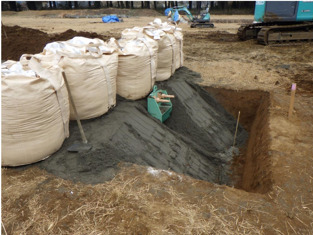
(参)写真-45 フレコンバッグ設置
