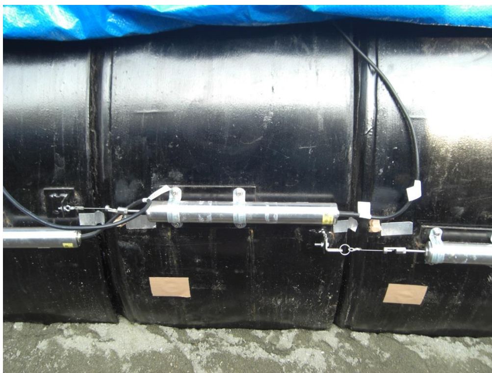
写真3. 1 防水型変位計設置状況
