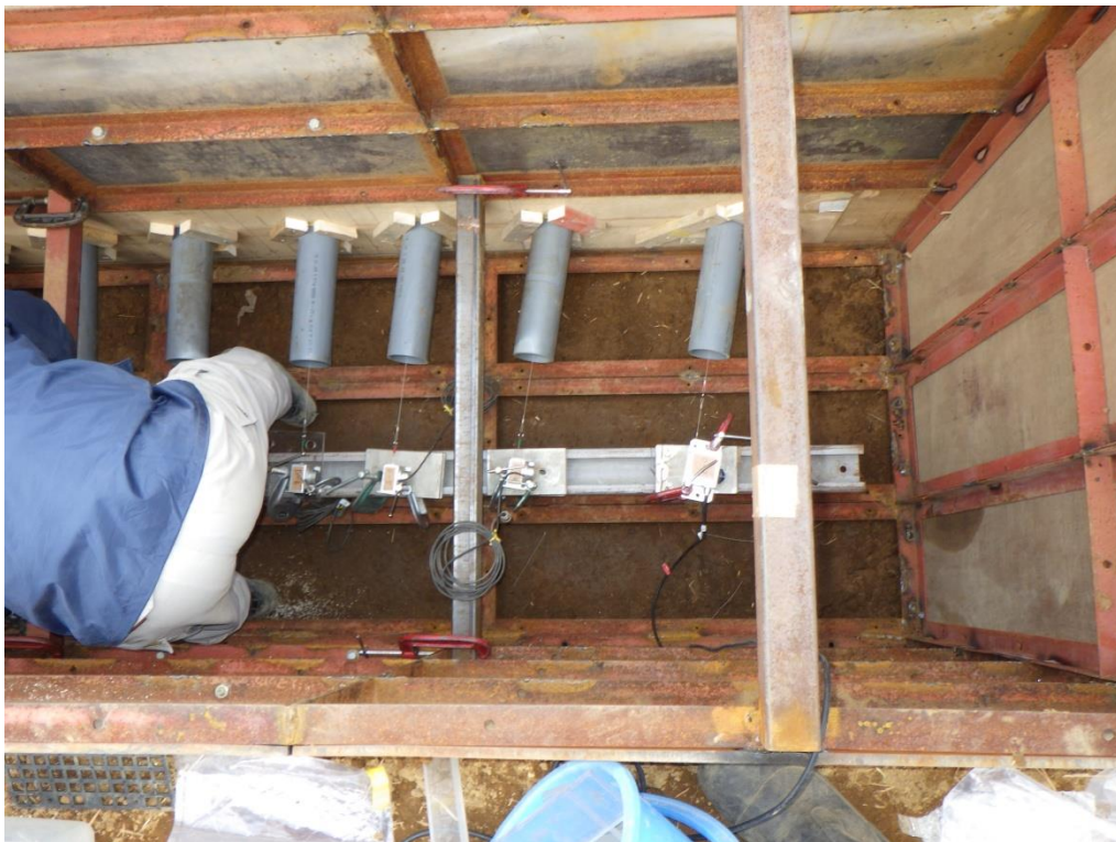
(参)写真-32 ワイヤ型変位計設置
