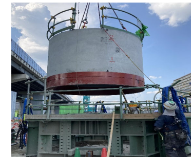
【PCウェル施工写真】
