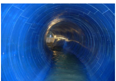
管更生（3Sセグメント工法）
