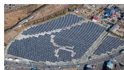
太陽光発電所
