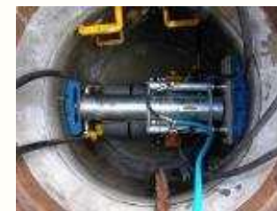
マンホール耐震化工事
