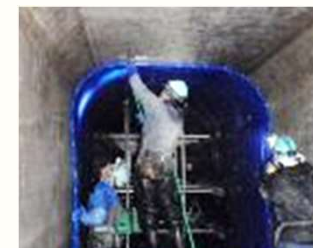
管渠更生工事
