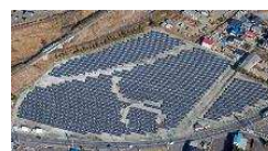
太陽光発電所
