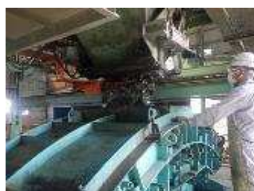
【コンクリート打込み状況】
