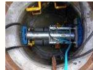
マンホール耐震化工事
