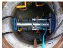
マンホール耐震化工事
