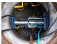
マンホール耐震化工事
