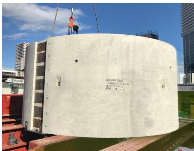
【PCウエル施工】
