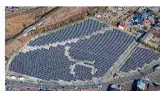
太陽光発電所
