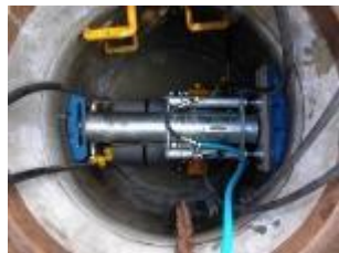
マンホール耐震化工事
