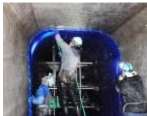
管渠更生工事
