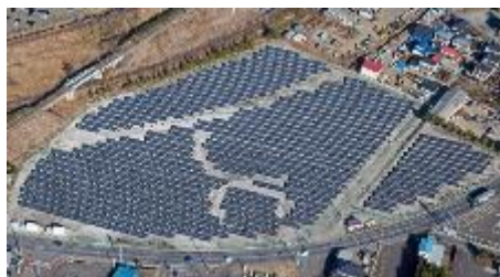
NH東北太陽光発電所
