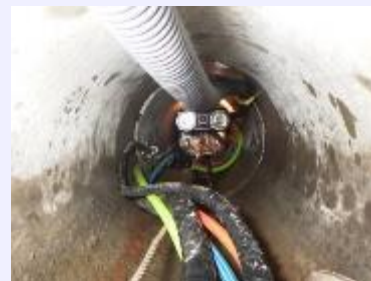
光ファイバーロボットによる水門の水位計用の電線配管（東京都） 下水道管路に、水門（排水樋門）の水位計用電線管を光ファイバー敷設用ロボットで敷設しました。
