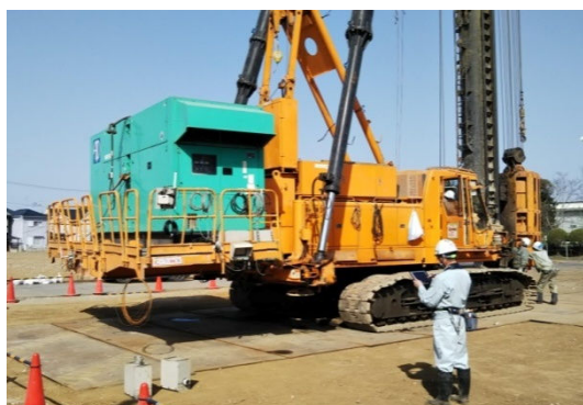
「i-Pile-ViMSys」による作業風景
