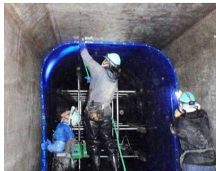
管渠更生工事
