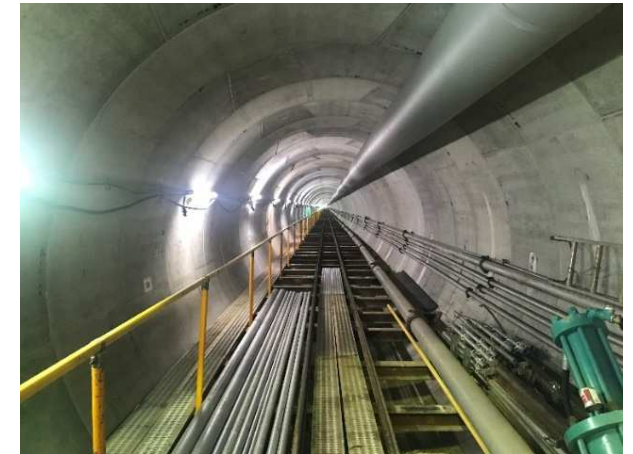
雨水貯留管：RCセグメント
