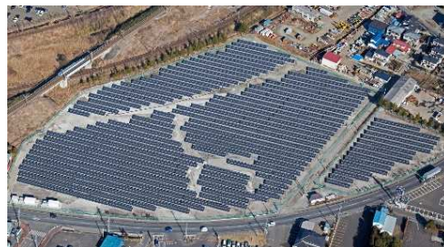
NH東北太陽光発電所
