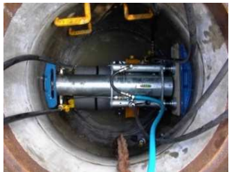
マンホール耐震化工事
