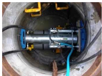
マンホール耐震化工事
