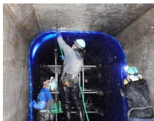
管渠更生工事
