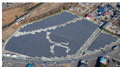
NH東北太陽光発電所
