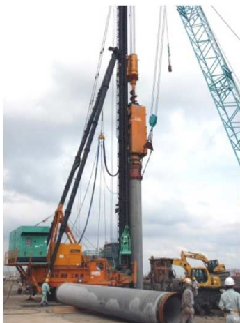
パイル施工(中掘工法)
