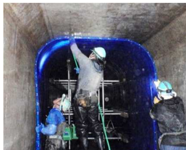
管渠更生工事
