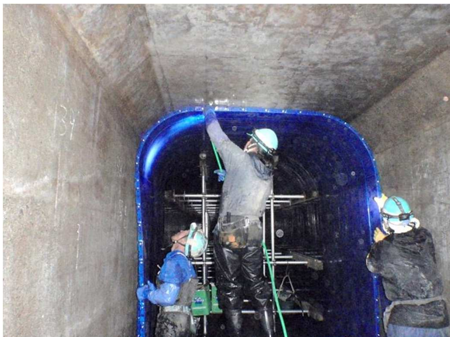
下水道管の更生工事
