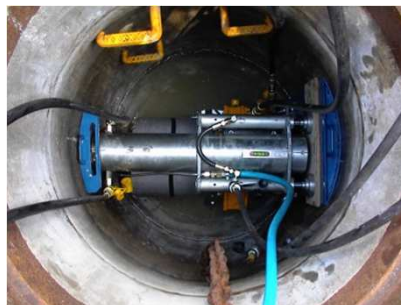
マンホール耐震化工事
