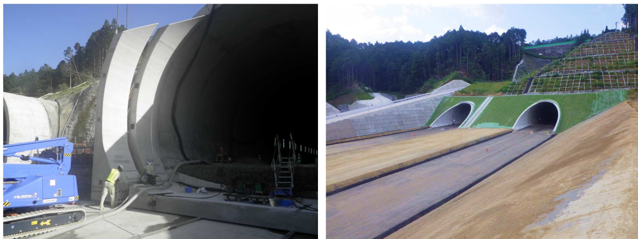
高速道路のトンネル坑口における プレキャスト製品化
