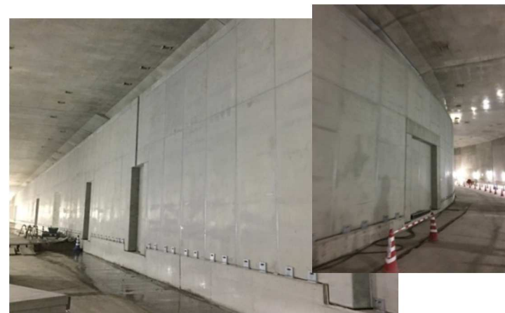
高速道路 避難用地下通路の 壁面プレキャスト製品化 19
