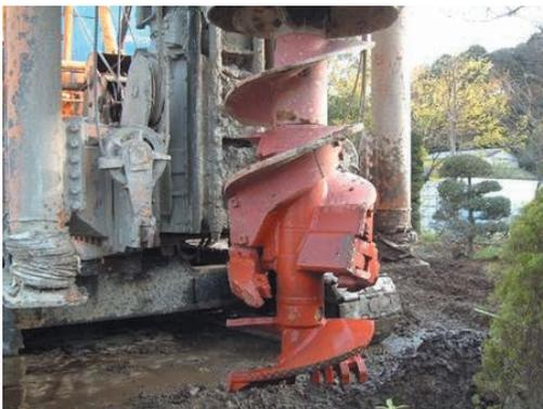
逆転拡大翼 拡翼 & 高圧ジェット噴射時
