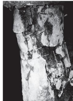
杭頭を剛接した杭の被害例
