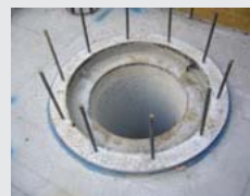
(1)杭内面の清掃
