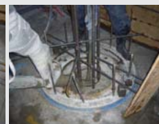
(3)中詰コンクリート打設状況
