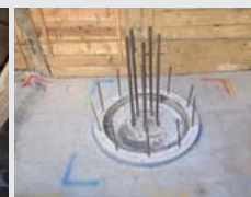
(4)コンクリート打設後
