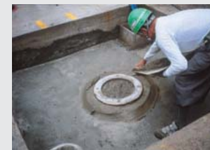
(2) 杭頭にモルタルを敷く
