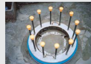
(4) PCリング設置完了
