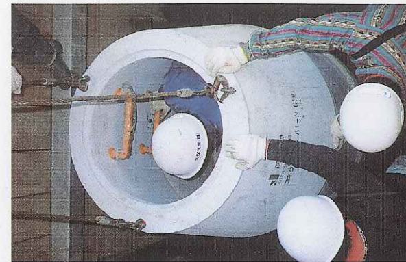
⑦ 斜壁据え付け
