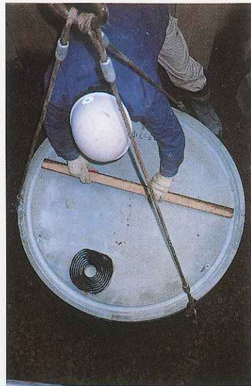
① 底版据え付け
