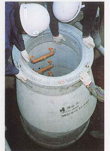
⑩ 調整リング据え付け (コネクテープ)
