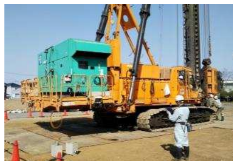
Pile-ViMSysを用いた作業風景
