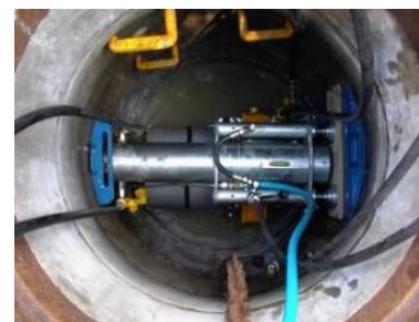
マンホール耐震化工事
