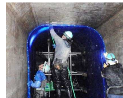
管渠更生工事
