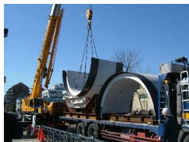
組立式超大口径推進管
