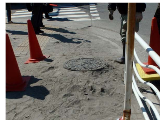
フロートレス工法（マンホール浮上抑制工法）
