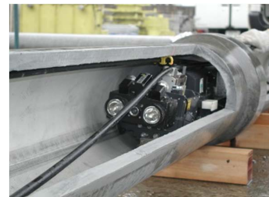
光ファイバーケーブル敷設工事
