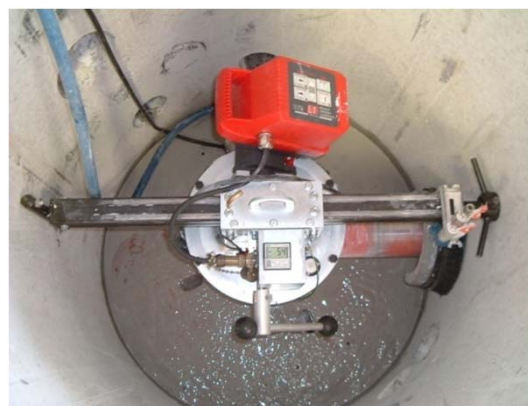
フロートレス工法（マンホール浮上抑制工法）
