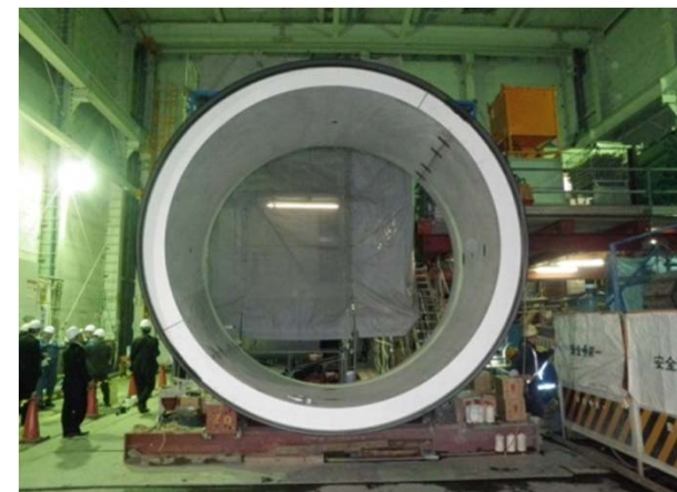
超大口徑推進管(直径4m)
